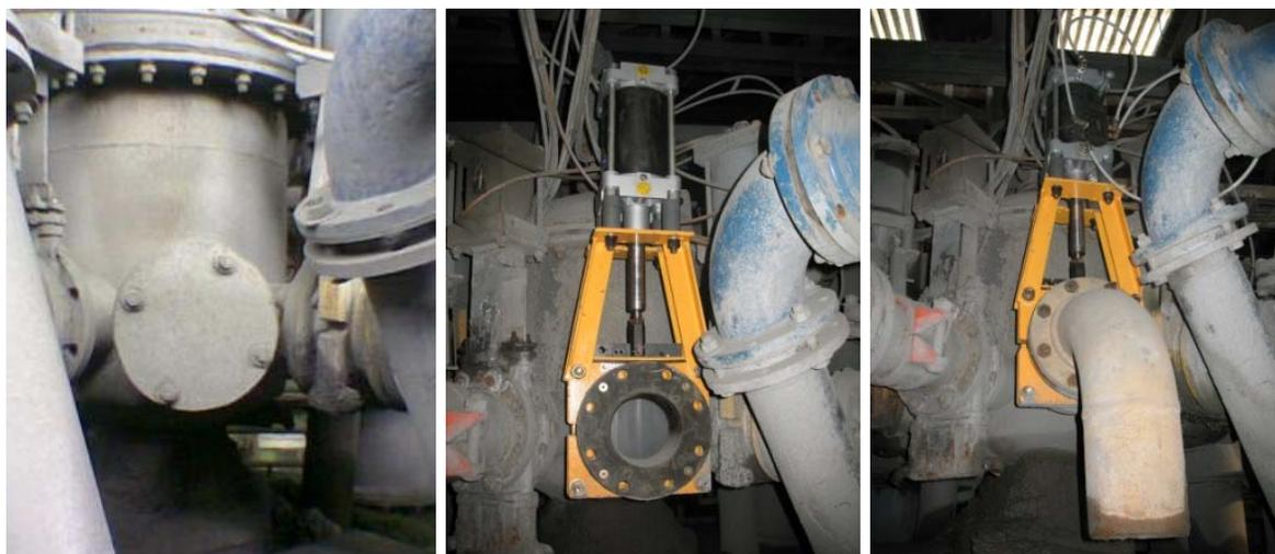
La válvula se instaló con un control manual (local), para que se pueda utilizar cada vez que se estime conveniente.
