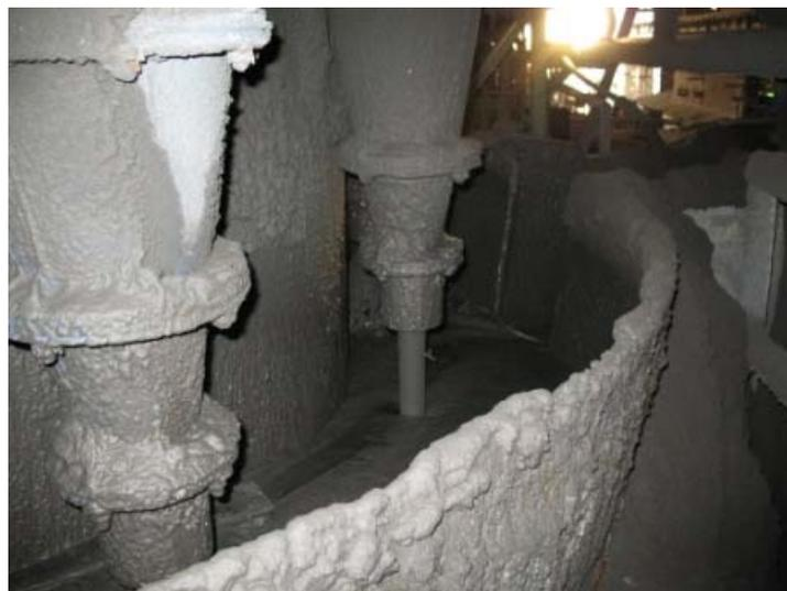
Para evitar esta situación se agrega agua mediante una red auxiliar contra incendios, permitiendo que la pulpa fluya de mejor manera y así evacuar la pulpa del launder, ver figura 5.13.
