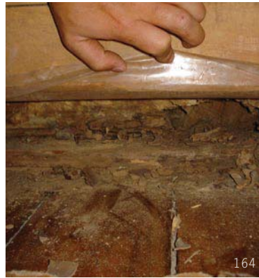
164 Estado de pudrición en unión interior entre piso y muro de madera 165 Putrefacción de vigas y entablado del lado suroriente
