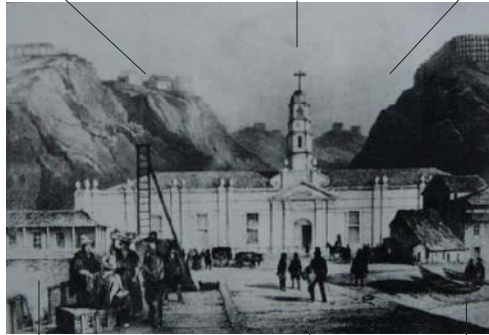
muro de contención muelle orilla natural (arena)
