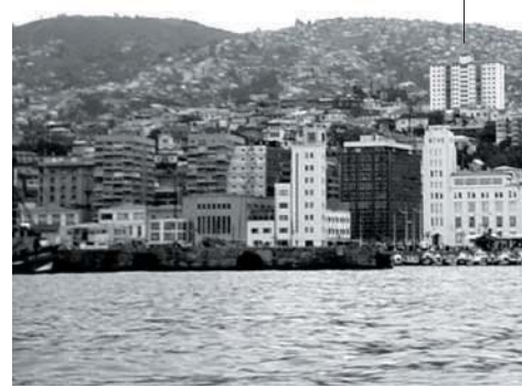
Vista actual del lugar ocupado por el Malecón.
