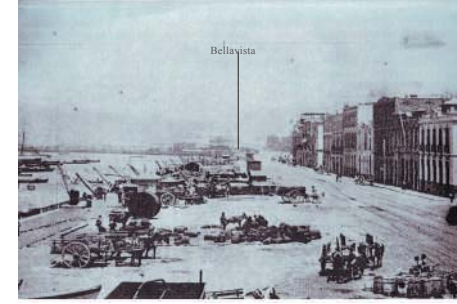
Profundidad expuesta de borde: grúas, acopio, carretas, avenida, fachada corrida.
