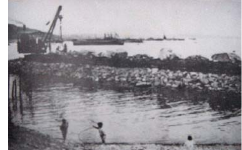
Obras de relleno y avance sobre el mar: terraplenes y pozas en desecamiento previo al relleno con escombros y desbastes de cerro.
