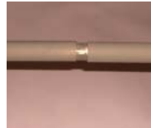
4.A Insertar traslape en el otro extremo
