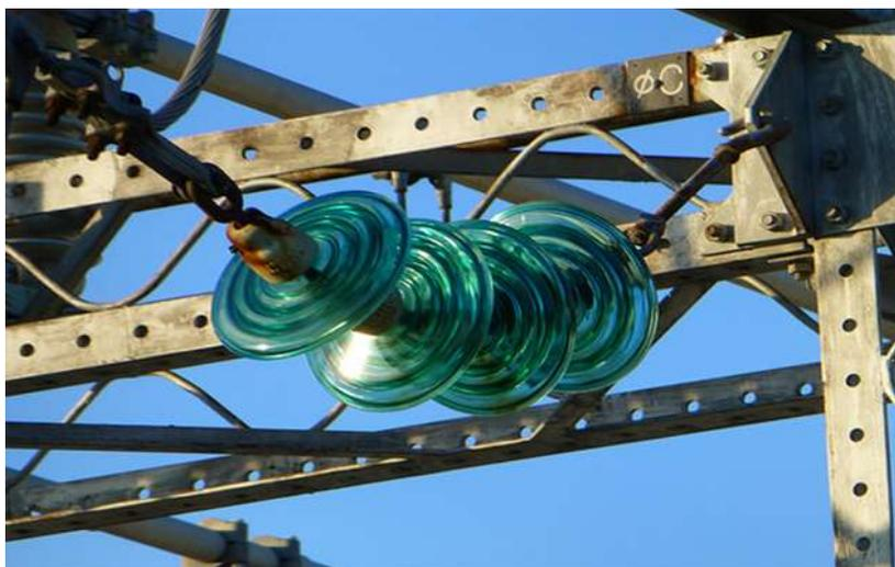
Figura 3-22: Aisladores de vidrio a utilizar (fuente: <http://electropowerjlc.com>)
