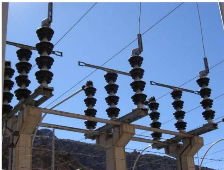
Figura 3-25: Seccionadores de columnas giratorias (fuente: <http://ingenieriaelectricaexplicada.blogspot.cl>)
