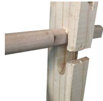
3. Fijación interior del travesaño 5. Travesaño fijo en la parte de arriba del corte
