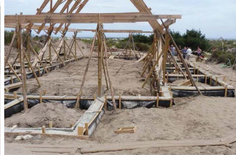
Fundaciones realizadas del Pórtico de los Huéspedes. Se observa aún la tela del encofrado para el vaciado del hormigón (moldaje flexible)[Figura 16 y 17]
