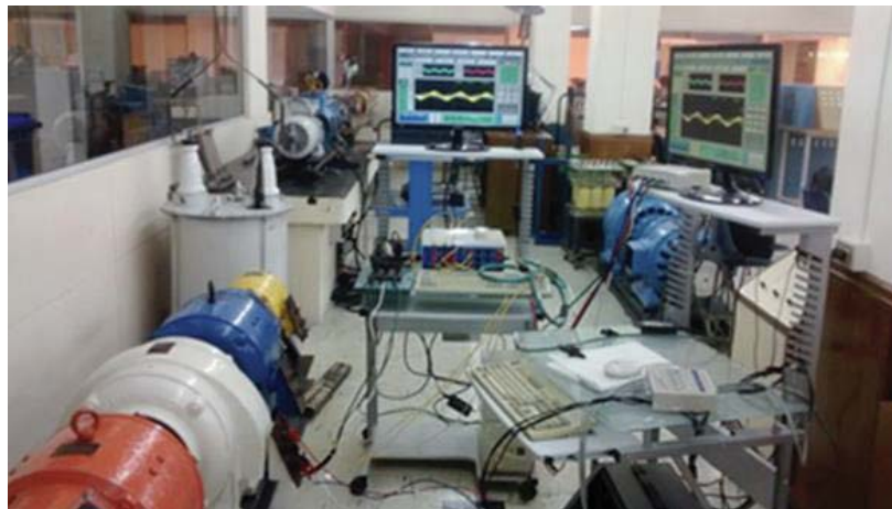
Figura A-25: Equipos SAMTE para mediciones de variables.
