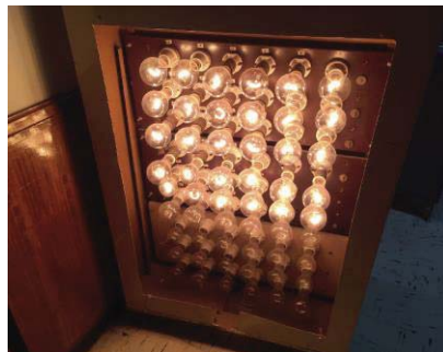
Figura 3-6: Ampollas utilizadas como carga resistiva conectada al generador
