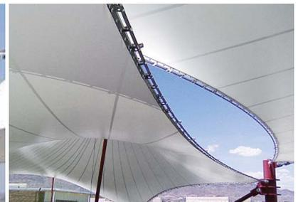
Es importante aclarar que la "tela" empleada en la arquitectura textil es un conjunto de fibras sintéticas hiladas, obteniendo una malla de fibras, la cual es recubierta por una capa plastificante impermeable. Desde el punto de vista del material empleado en la construcción de las membranas, las tenso estructuras son divididas en dos grupos fundamentales:
