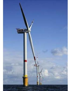
Asimismo, es necesario un sistema de control de las velocidades de rotación para que, en caso de vientos excesivamente fuertes, que podrían poner en peligro la instalación, haga girar a las palas de la hélice de tal forma que éstas presenten la mínima oposición al viento, con lo que la hélice se detendría.
