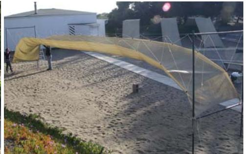
Es una estructura conformada por seis mallas sujetas por argollas a piolas de acero a través de cerchas móviles de cuerda.
