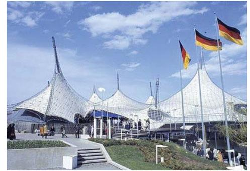
Pabellón alemán para la exposición de 1968 en Montreal y los techos tensados de las olimpiadas de Munich, ambas de Frei Otto, constituyeron el punto de partida para la generación de estructuras espaciales. Mediante el uso de acero, lonas de pvc y cables de tensión. Estructura tensada, solución ya adoptada en las tiendas de campaña, en este caso, una dimensión mucho mayor y su solución compleja de mástiles y enlaces. se mantiene la idea de guarida y cubierta que siempre ha tenido,
