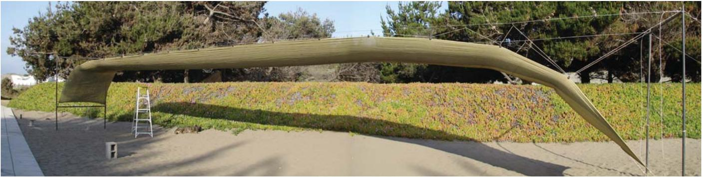
Se vuelve a replantear el proyecto como un nuevo modelo e innovación de la forma. Se propone unir en paños las mallas (dos o tres unidades); por consecuencia de su peso debe ser una estructura que quede en un lugar fijo, que sea de armado fácil, con la malla desmontable, pero no una estructura móvil como se armó anteriormente.
