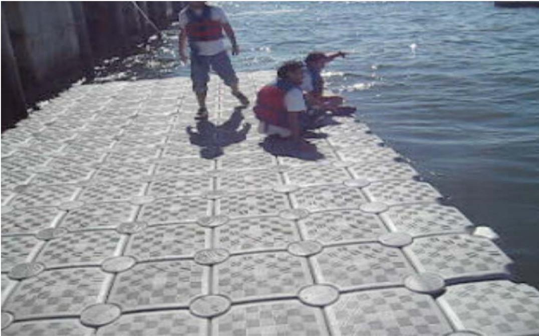
Figura 67. Construcción pontón Muelle Barón, Valparaíso, Región de Valparaíso. :[http://www.readydock.com/producto\\_es.html?gclid=CPXY3\\_373K0CFQmd7Qod2UNqnA](http://www.readydock.com/producto_es.html?gclid=CPXY3_373K0CFQmd7Qod2UNqnA)
