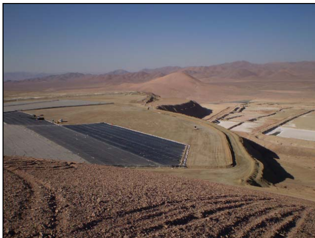
Figura 2.5 Pila de Lixiviación Secundaria de Ripios
