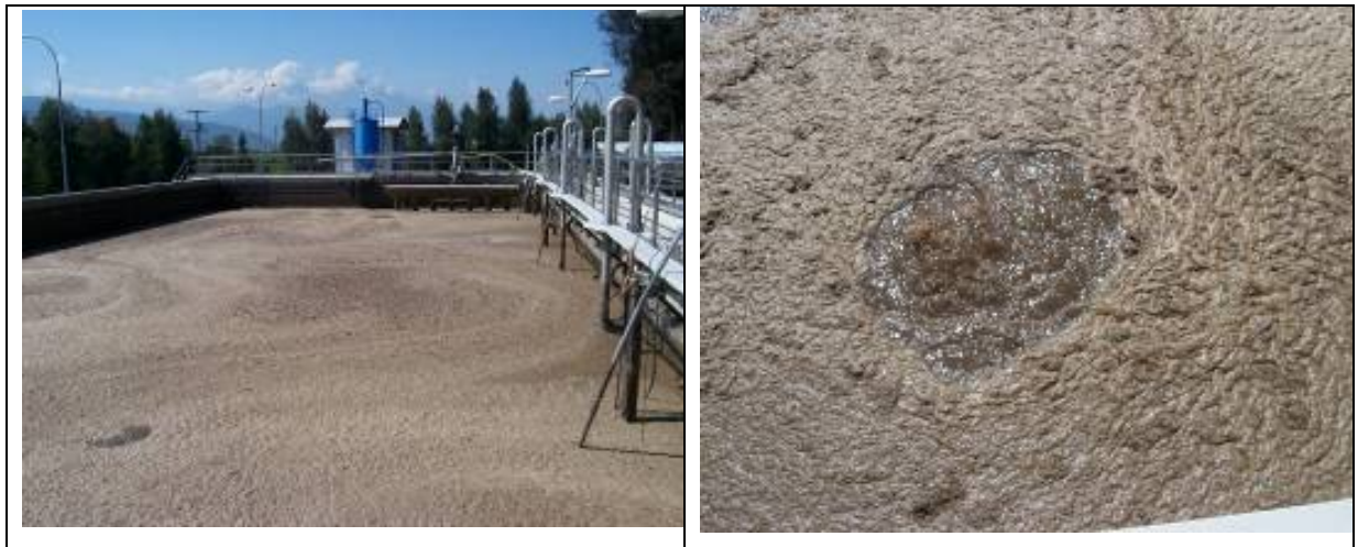
Figura 5-25 Imágenes antes de la aplicación de antiespumante.
