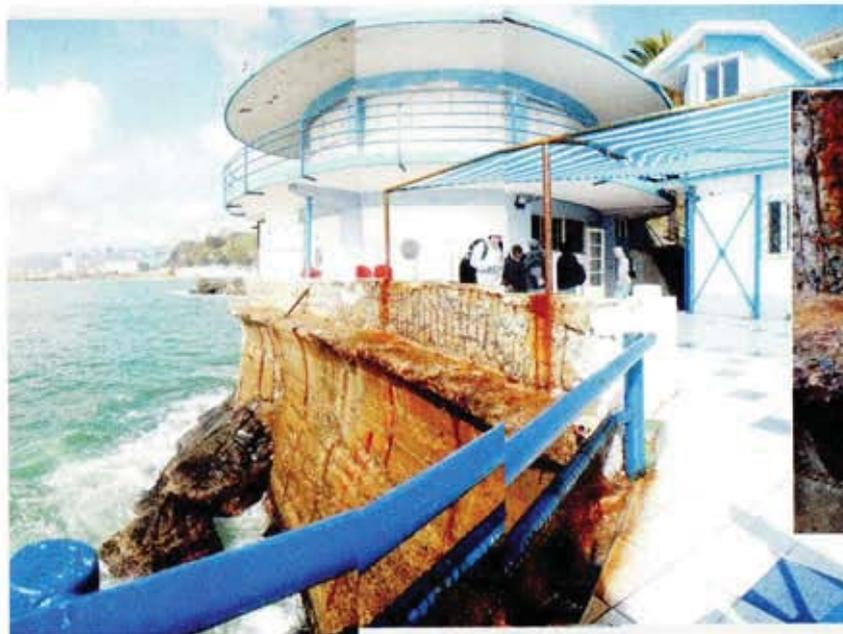
1. Muro de hormigón armado base del patio del edificio de docencia y protector de este patio contra las olas.
