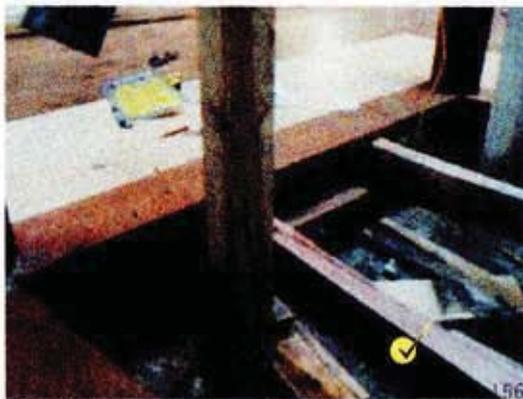
Vigas de roble para el piso central de la lucarna que esta a la intemperie. Las vigas con un corte curvo con pendiente hacia el centro.
