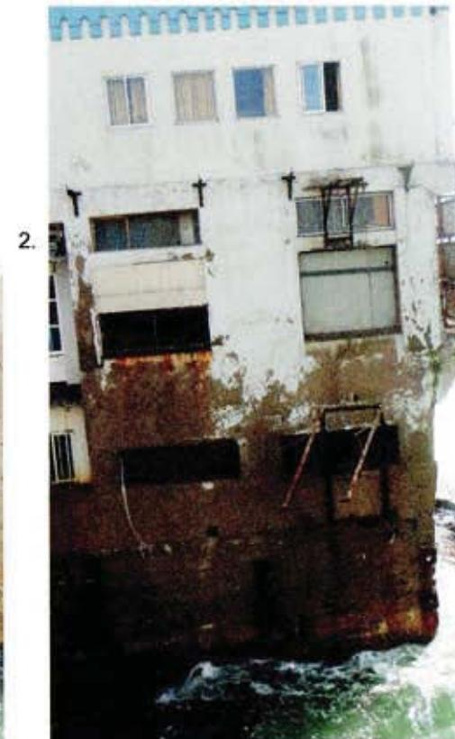
1 y 2. La parte inferior del muro de la fachada Sur del edificio del castillo esta fundado en roca y se ha ido construyendo a pulso. Es posible ver a primera vista los diferentes materiales que lo componen, toda esa fusion de materiales contribuye negativamente a la hermeticidad del muro produciendose filtraciones al interior, en el subterraneo del edificio.
