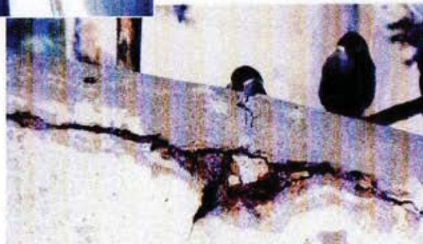
2. La losa del segundo piso en la zona del balcón está muy agrietada y con fierros expuestos.
