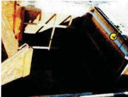
Se instalan perfiles de aluminio blancos como canaletas que bajan por los pilares de la lucarna y desaguan en el centro del prisma. Estos perfiles además constituyen el borde de la membrana asfáltica del techo exterior.
