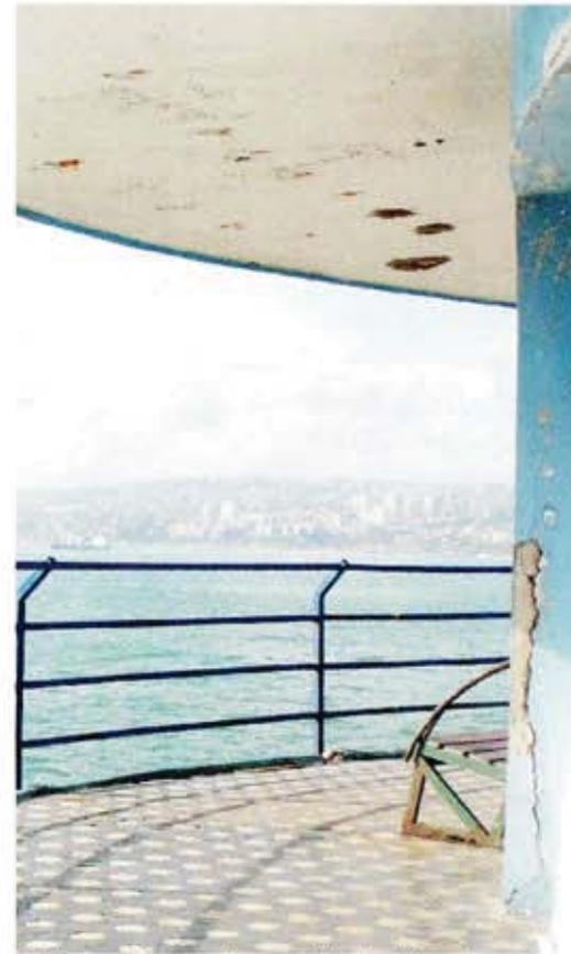
2. Fierros a la vista y desprendimiento de hormigón en losa de techo y grieta en pilar. Esto se repite en todos los elementos estructurales del edificio.
