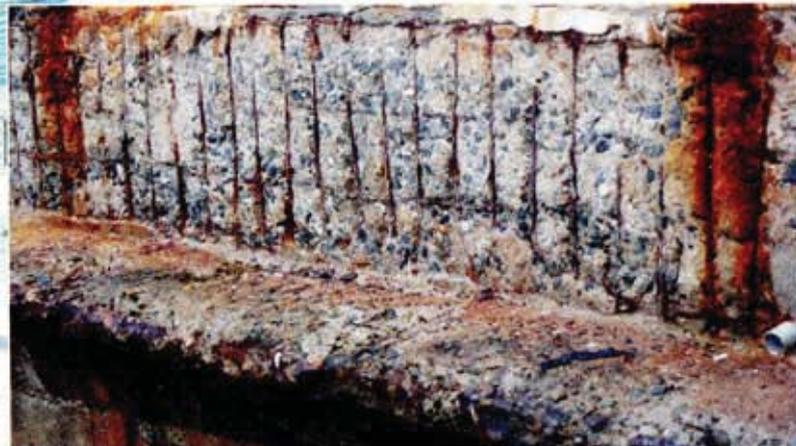
2. El estado del muro es de un deterioro por oxidación total, no es fácil que un muro de hormigón armado común y corriente sobreviva a tal oleaje del mar.
