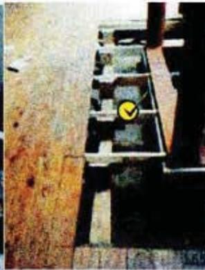
Vigas de piso interior listas para ser cubiertas con el entablado machihembrado de piso.
