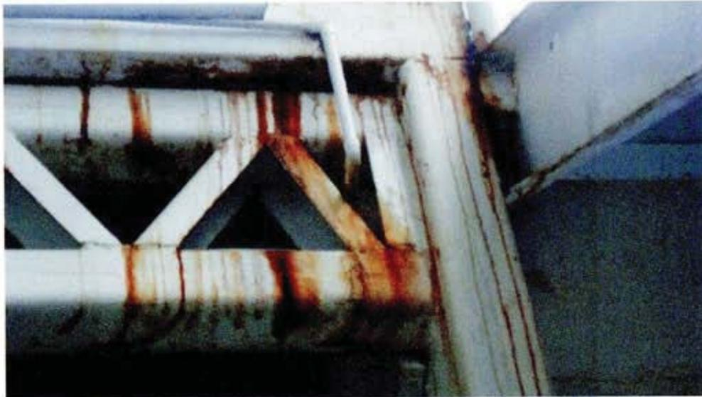
1. Viga de fierro oxidada. La estructura de éste laboratorio es completamente de fierro ensamblado, el oxido cae por todos los pilares inevitablemente, se trabaja con muestras del mar y es un salon que está constantemente humedo, es tal la humedad que los productos para fierro anti oxido no dan avasto.
