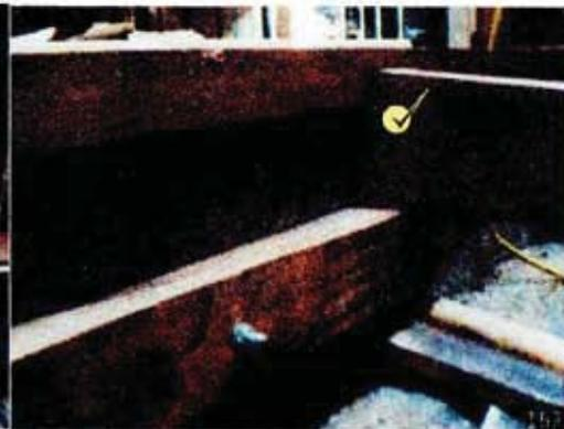
Cortes en las vigas que permite fijarlas a la estructura central de la linterna.
