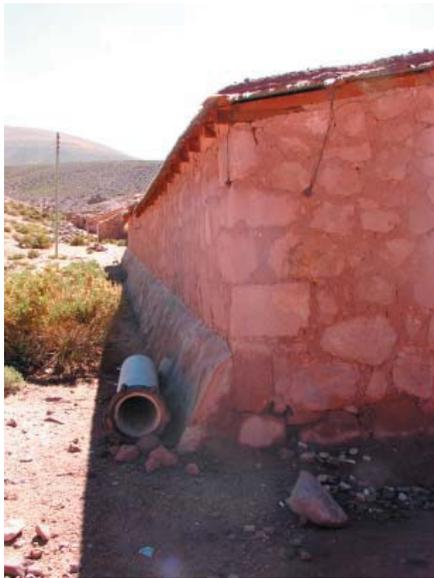
En el caso de la vivienda en el Pueblo de San Pedro, los cimientos aíslan del calor mediante la separación del muro con el terreno exterior y asientan la estructura.
