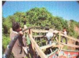
Detalle del armado y presentación de la circunferencia previa triangulación de las marcas de ajuste.
