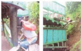
Detalle de la colocación y presentación de los vínculos inferiores, para lo cual se desvastaron, semi-cortaron y perforaron los pilares de madera de la escala pentagonal.
