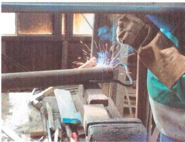
Detalle del soldado de los estribos al extremo superior de los pilares (tubo de 2 1/2 x 3mm) que conforman la estructura auto-soportante.
