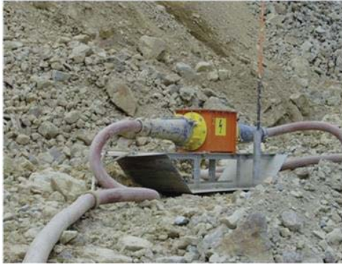
Figura 2-6: Trineo de conexión de cable minero a cargas – Fuente, Elaboración Propia.
