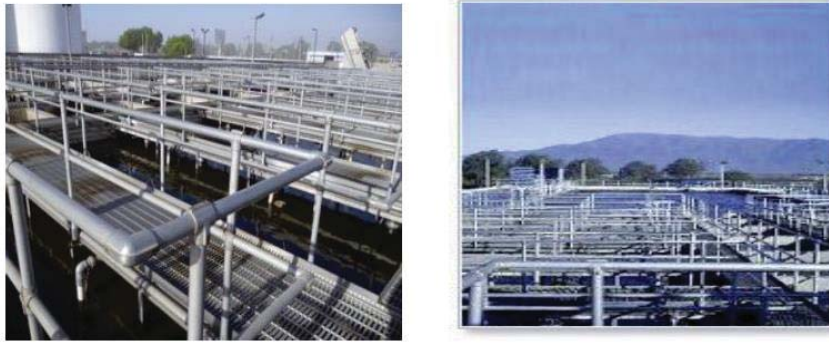
Figura 3-10: Sedimentadores secundarios existentes (fuente: http://www.mop.cl )
