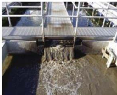
Figura 3-11: Llegada del RAS al estanque bioselector por un canal de RAS (fuente: http://www.mop.cl )
