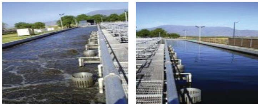
Figura 3-8: Estanque lateral del sur (izquierda) y estanque lateral del norte (derecha) (fuente: http://www.mop.cl )
