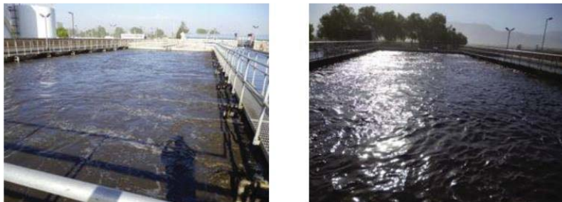
Figura 3-5: Estanque de aireación o reactor biológico existente (fuente: http://www.mop.cl )
