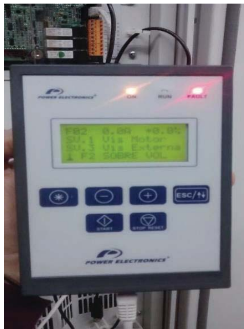
Figura 4-11: El display del variador de frecuencia SD 700 arroja fallo de sobre tensión en el bus DC
