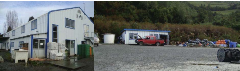
Figura. 27: Galpón de oficinas y servicios (izquierda). Galpón de mantenimiento (derecha).
