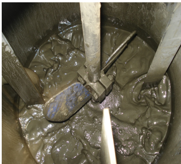
Figura 30: Estanque alimentación. Vista Superior.
