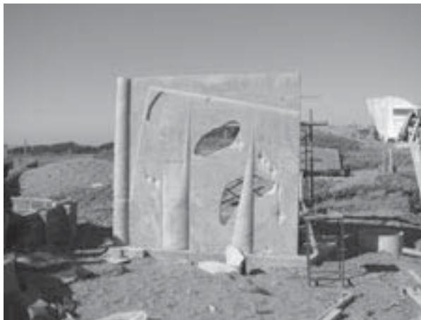
Fotografía del resultado del muro propuesto para los baños, con sus aberturas y sus relieves, los que le ofrecen a este muro una cierta identidad a través de lo particular.
