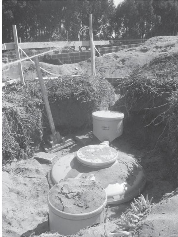
La fosa séptica instalada queda a unos 70 cms. del nivel de suelo , una buena altura para evitar malos olores y para que también se pueda destapar con una cierta facilidad de manera de cuidar su limpieza.
