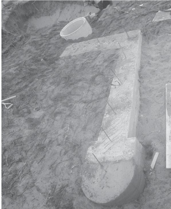
La construcción de la fundación del muro West se hace evidentemente en base a hormigón armado y será de grandes dimensiones para garantizar su resistencia dado el hecho también que nos encontramos construyendo sobre la arena.
