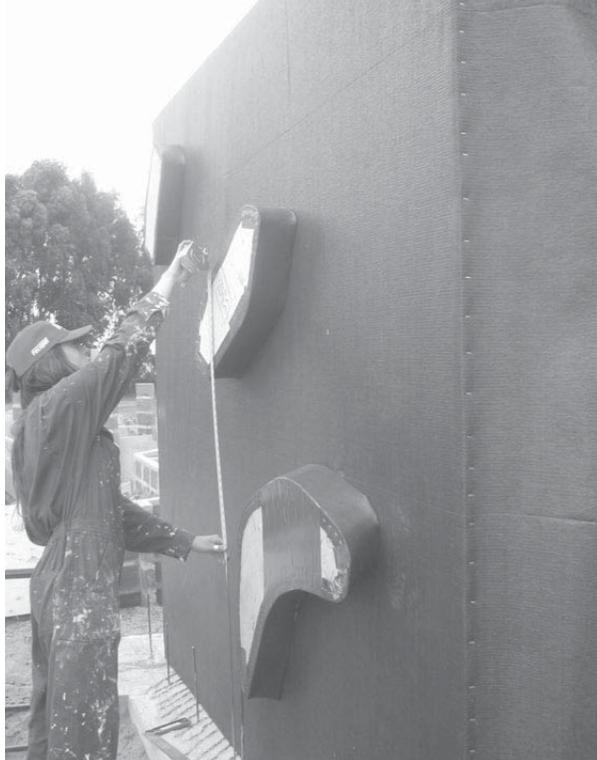
Los volúmenes de madera deben ser, al igual que todo el interior del moldaje, revestidos con una capa de tela geotextil que permite que escurra el agua pero no el hormigon.
