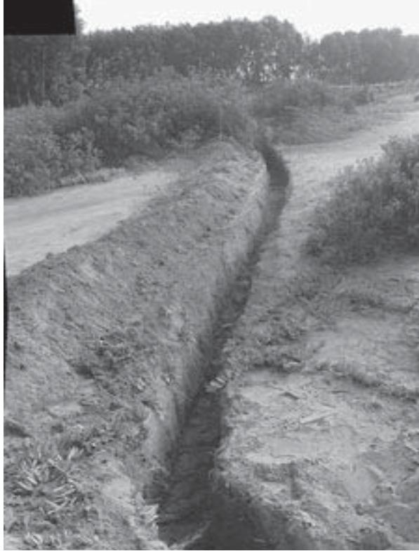
La foto nos muestra el herido dentro del cual irá la cañería de conexión de 32mm de agua potable entre la matriz y la red de agua de la propia obra
