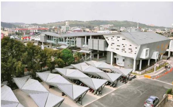
Estacionamientos vehicular multimodalidad protegida de la exposición.
