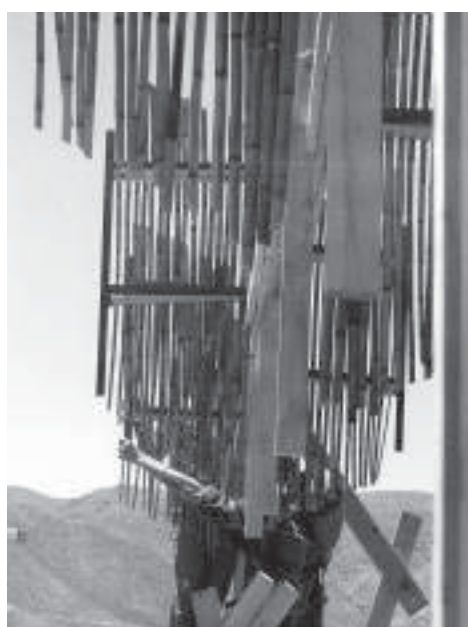
Instalación de celosías de bambú y madera
