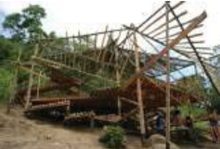
Vista desde su parte baja. Aparece el desivel y las máximas de la obra.
