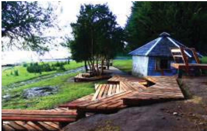
Totalidad obra. Umbral entre límite mar y densidad- sombra de los árboles.
