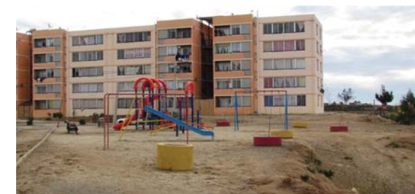
Fig 104. Plaza con juegos infantiles en ultima etapa de regularización.
