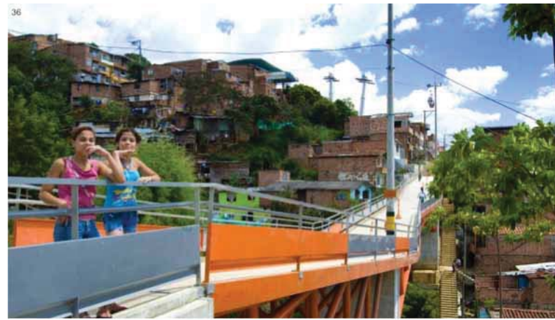
Fig 128. Vista puente mirador Andalucía- Francia.
