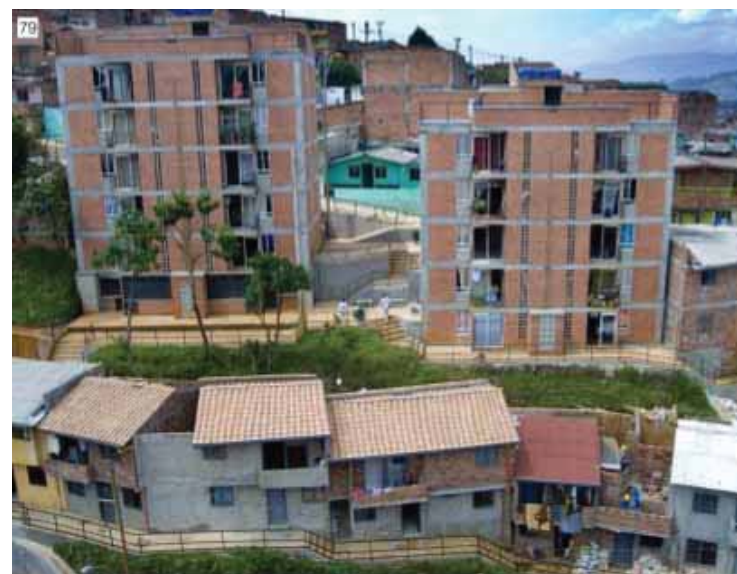
Fig 138. Edificación de vivienda nueva en quebrada Juan Bobo.
