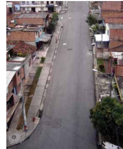
Fig 121. Estado previo a intervención calle 107.
