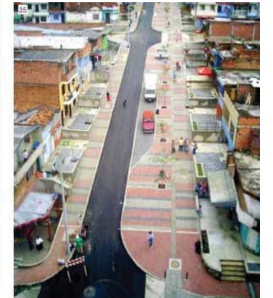
Fig 123. Paseo Andalucía, calle 107 después de intervención PUI.
