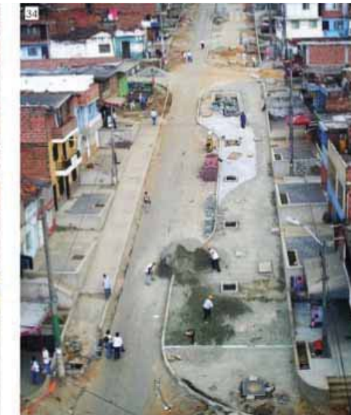
Fig 122. Proceso de intervención calle 107, futuro Paseo Andalucía.
