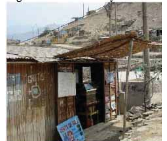
Fig 100. Casa- tienda en proceso de consolidación en el barrio de Huaycán, Lima.
