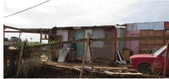
Fig 91. Asentamiento irregular del sector.
