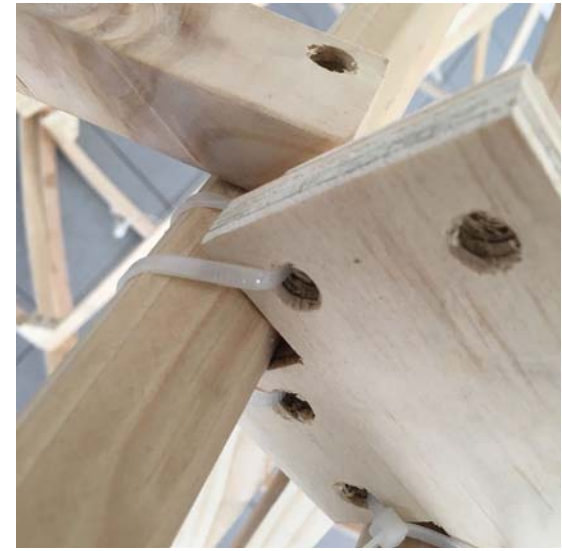
Detalle de la pieza interior amarrada al eje con amarracables
