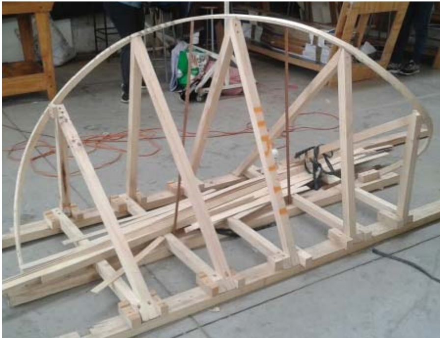
A los triángulos se le adosan láminas de terciado, las que forman la curva-matriz.
