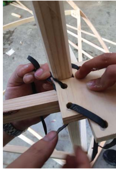
Prueba de amarre de la pieza interior
