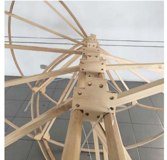
Disposición de las 5 piezas centrales amarradas a los ejes de los gajos
