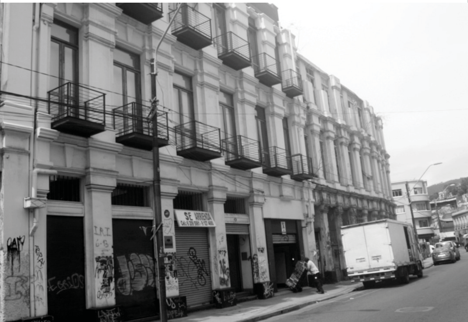
Imagen 4. Rehabilitación edificio habitacional – calle Blanco – Barrio Puerto – Valparaíso
