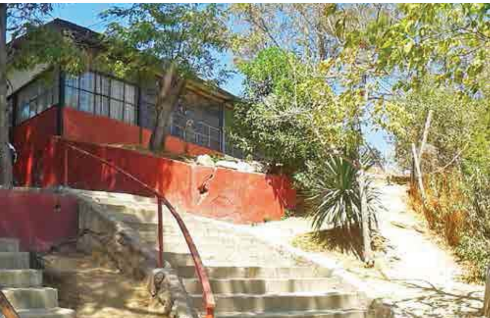
Acceso a escuela desde atrio con escaleras.
