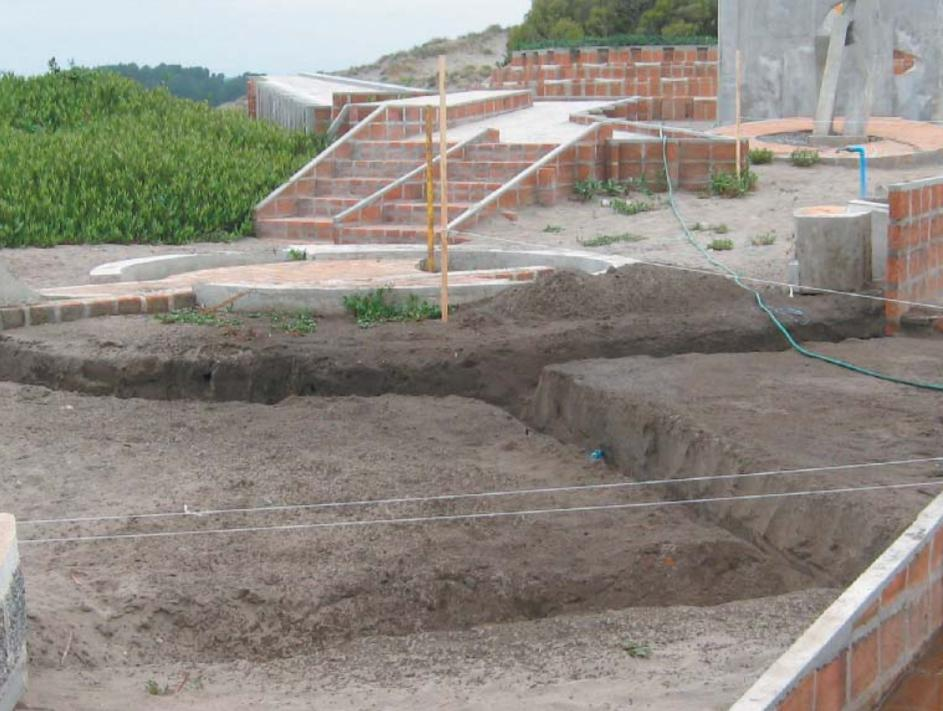
Cavado de las zanjas para los emplantillados de los niveles de ladrillo.
