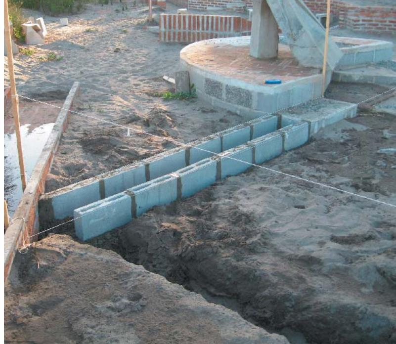
Ejecución del primer nivel en bloques de Hormigón.
