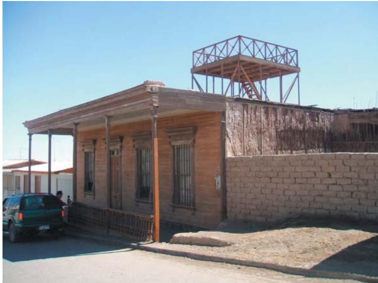
fig 145/ Imagen de casa de caña forrada en su fachada con madera. Todas estas construcciones presentan el alero en la fachada para sombrearla. Esto construye un habitat en torno a la calle en momentos en que el calor intenso baja. La gente se ubica en sus fachadas de manera que identifique su propiedad pero a tal punto que la hace pública ya que comparte su modo de habitar. Otro modo de cerrar las fachadas es con planchas de lata, calaminas.
