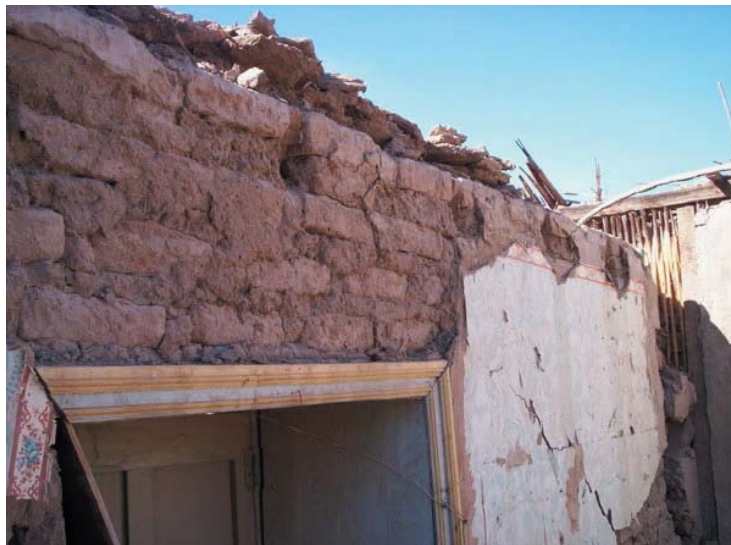
fig 147/ Los techos son principalmente planos contruidos de paja, madera y adobe. En este detalle nuevamente se logra apreciar la profundidad de los muros de por lo menos 35cm .
