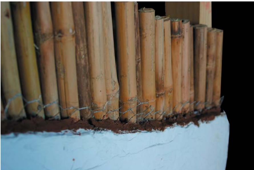
maqueta detalle del material QUINCHA e s c a l a 1 : 1
