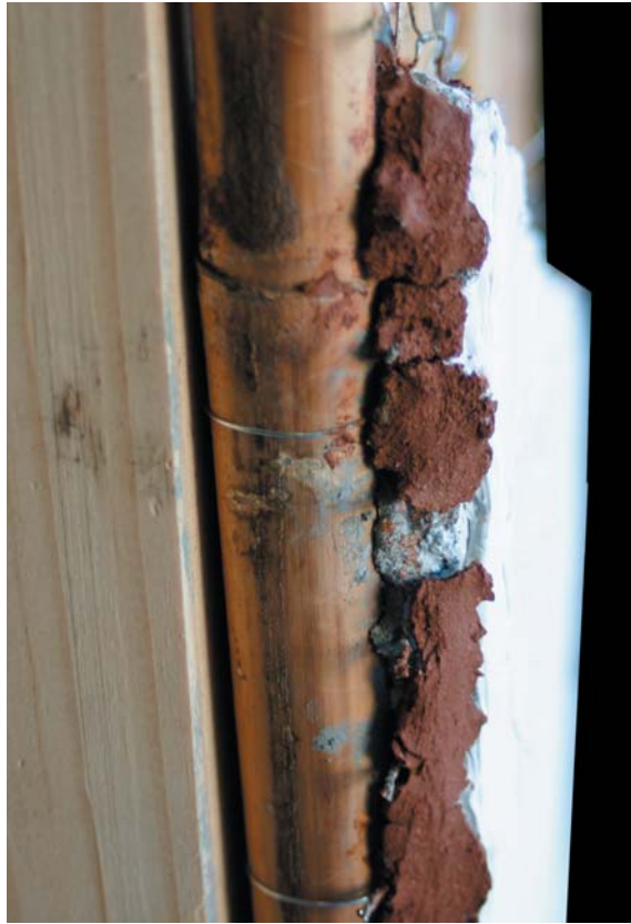
maqueta detalle del material QUINCHA e s c a l a 1 : 1
