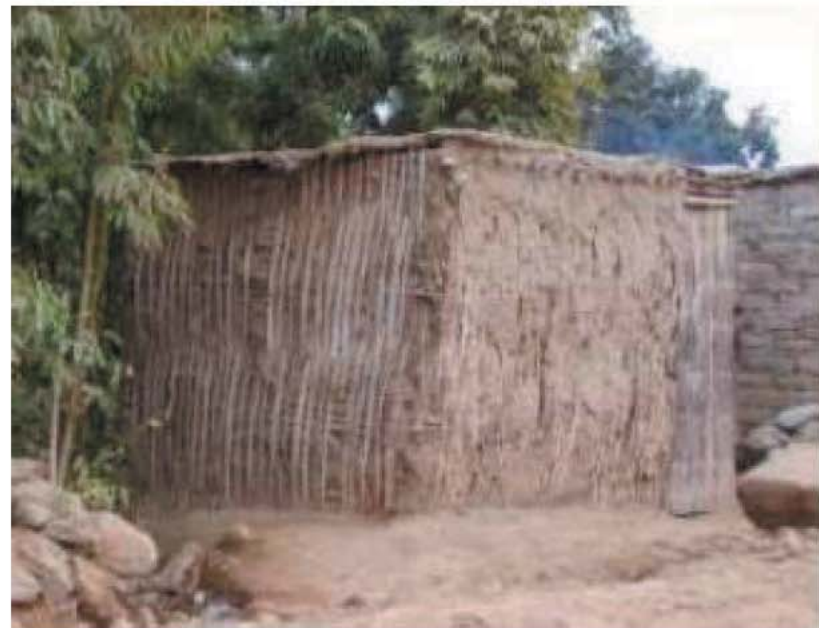
fig 193 Edificación de Quincha revestida con adobe, sin embargo se deja entrever el entramado de caña.
