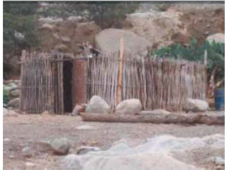
fig 192 Chozas rústicas construidas con Quincha, en este caso no contiene el revestimiento de tierra.
