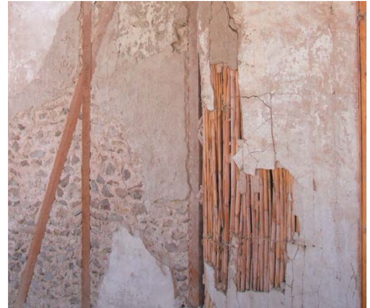
fig144/ Imagen vivienda de construcción de caña. En algunos casos la caña va cubierta por piedras como refuerzo adicional y para una mayor hermeticidad. Las construcciones mas actuales de caña incluyen cemento en sus capas exteriores para dar mayor firmeza.
