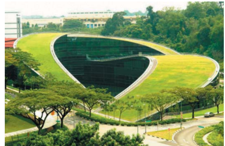
fig 7/ edificación verde. Edificio en Singapur , Universidad Tecnológica de Nanyang. La cubierta es utilizada como aislante térmico
