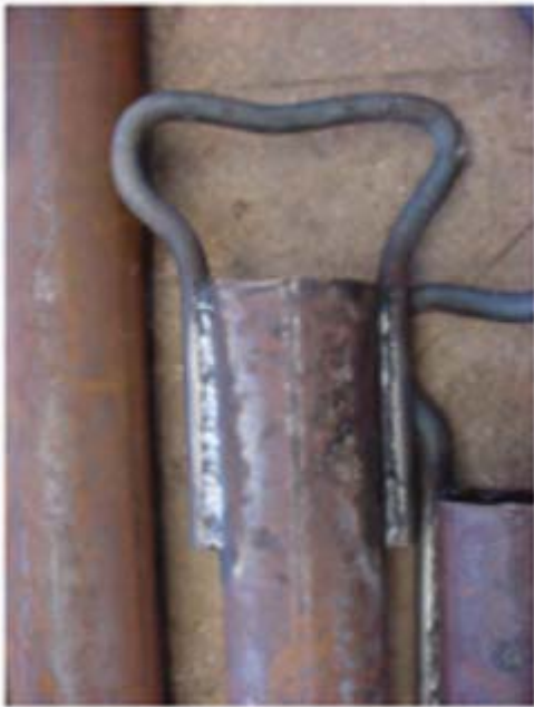
Estribo utilizado en el extremo superior de los pilares, que posteriormente se une al anillo.
