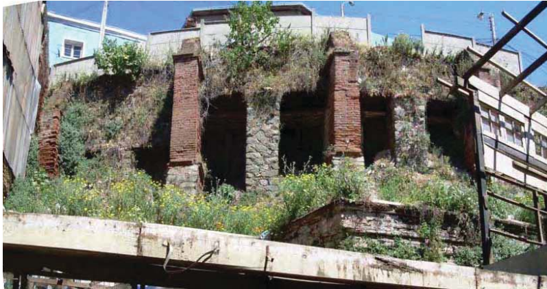
Detalle de los abotantes que cumplen la función de contener toda la carga del pasaje Ulises y del cerro Santo Domingo.
