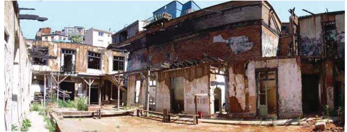
Aspecto del interior del edificio. Se puede apreciar el quiebre del muro de contención al lado derecho y la relación de altura existente en relación al pasaje Ulises en el fondo.
