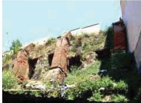
Detalle de los abotantes que cumplen la función de contener toda la carga del pasaje Ulises y del cerro Santo Domingo.
