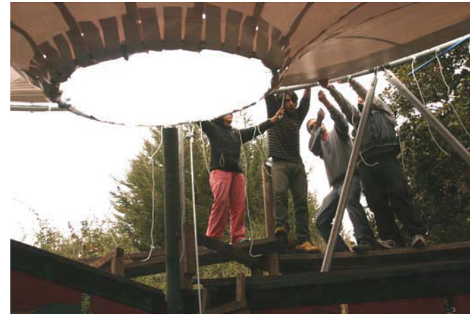
Finalmente luego de amarrar todas las cuerdas en la posición deseada, éstas se vuelven a apretar, de manera que el manto quede lo más tenso y centrado posible.
