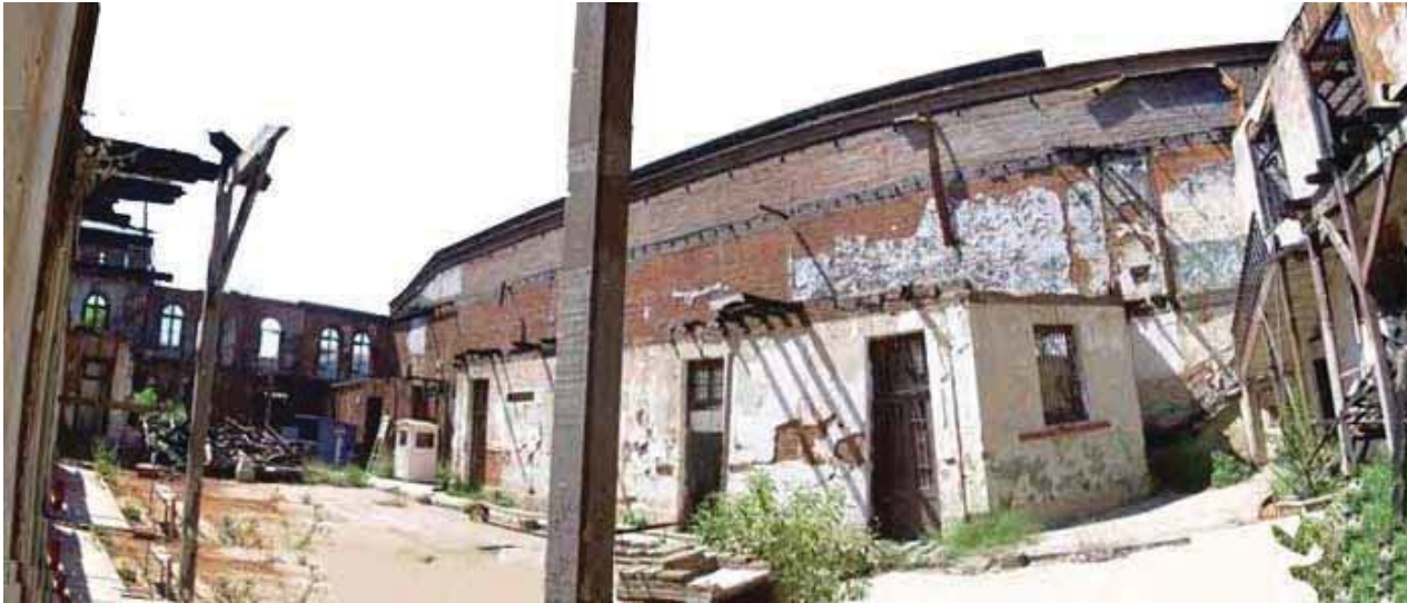
Muro cortafuego Sur
