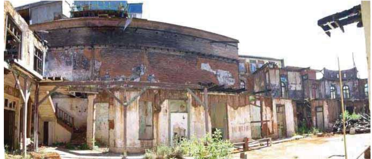
Muro cortafuego Norte
