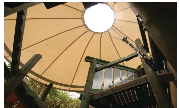
Vista desde el interior de la escalera, se aprecia la forma de anclaje del anillo menor del manto al pilar de la escalera
