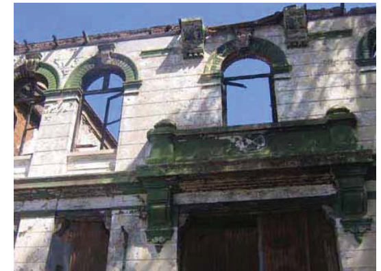
Detalle de la estructura de las ventanas y sus vanos.
