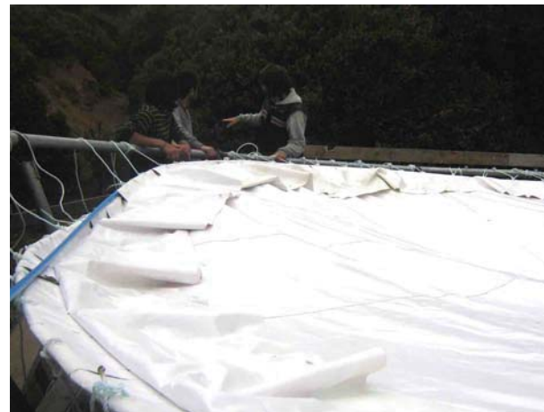
Instalación del manto en el anillo metálico. Las cuerdas actúan como tirantes que fijan al manto en su posición final
