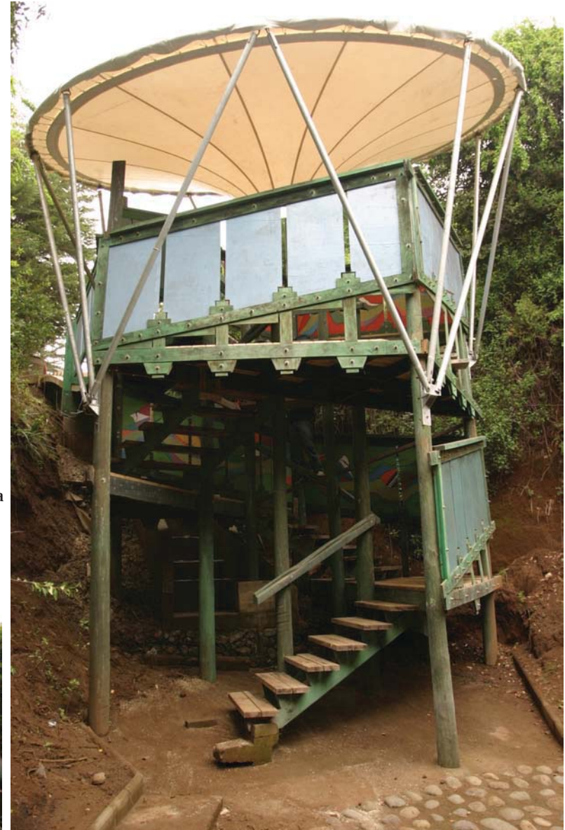
Vista general de la obra terminada
