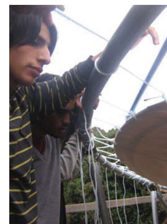
Instalación del manto en el anillo metálico. Las cuerdas actúan como tirantes que fijan al manto en su posición final
