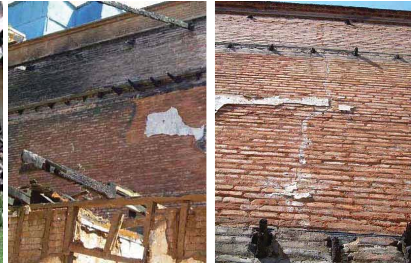
Detalle de los muros de contención, se puede apreciar la ubicación de las vigas que estructuraban los pisos del edificio
