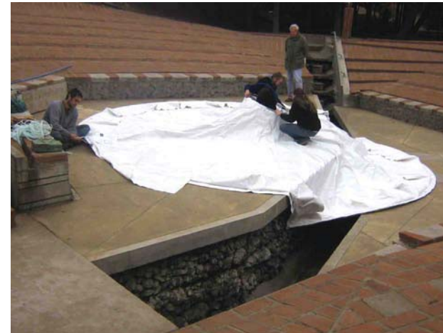
Armado del anillo menor mediante la instalación de la argolla metálica, otorgándole la rigidez que necesita
