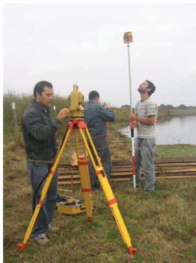
Preparación del equipo para el levantamiento
