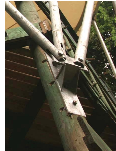
Detalle de la pletina, que mediante sus ángulos dirige a cada pilar hacia la posición de encuentro con el anillo, en la parte superior.
