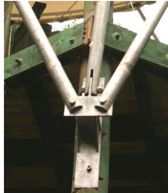
Detalle de la pletina, que mediante sus ángulos dirige a cada pilar hacia la posición de encuentro con el anillo, en la parte superior.
