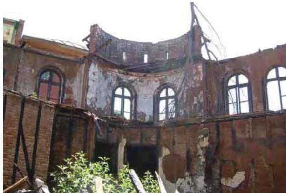
Aspecto del tomeón luego del siniestro. La superficie que da hacia el interior se encuentra mucho más deteriorada que la que da hacia el exterior.
