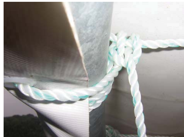
Luego de fijar las cuerdas con un segundo nudo al anillo metálico se procede a cubrir el anillo con una funda del mismo manto para que el agua no lo deteriore
