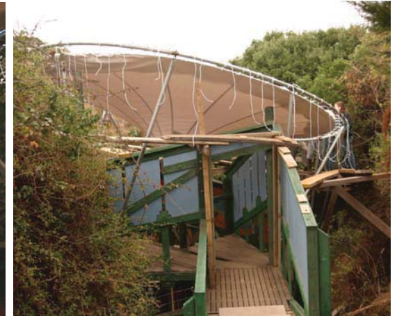
Finalmente luego de amarrar todas las cuerdas en la posición deseada, éstas se vuelven a apretar, de manera que el manto quede lo más tenso y centrado posible.
