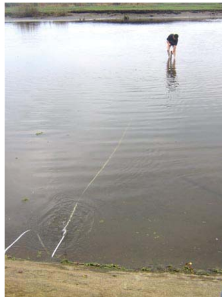
Ubicación y clavado de la primera estaca, que nos dará la referencia
