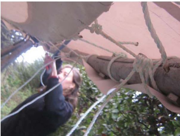
Luego de fijar las cuerdas con un segundo nudo al anillo metálico se procede a cubrir el anillo con una funda del mismo manto para que el agua no lo deteriore
