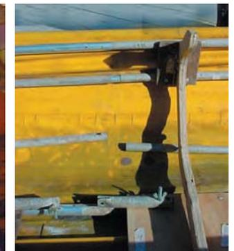
A diferencia del extremo opuesto este polo no se inserta (ya que posee el mismo diámetro), se alinea. Para ello se debe levantar ambas partes, enfilar y, con suavidad, empujar hacia abajo.
