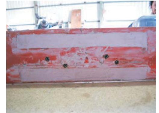
Se realiza el sacado correspondiente para poder colocar la pieza.
