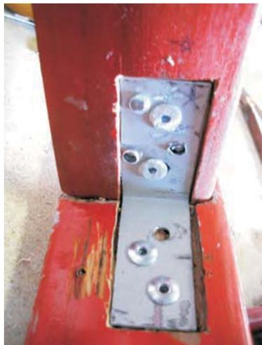
Se realiza la unión de las alas, mediante las piezas de vínculo, las cuales van remachadas a la madera.
