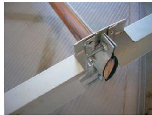
Al ajustar los pernos, éstos juntan las pletinas (que tienen la forma del perfil), presionando, de este modo, el perfil hidrodinámico vertical.
