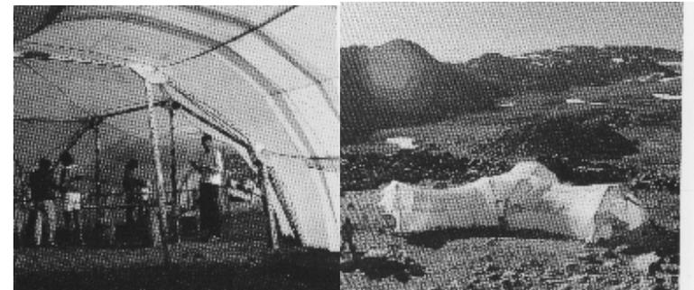
MEMBRANAS TENSADAS POR DIFERENCIA DE PRESIÓN.
