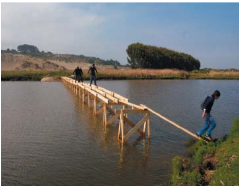
Colocación de las vigas sobre los caballetes.
