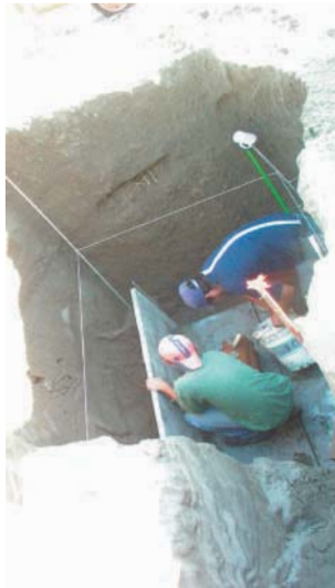
Trabajo en la construcción de cámara decantadora. Colocación de losetas prefabricadas de hormigón.
