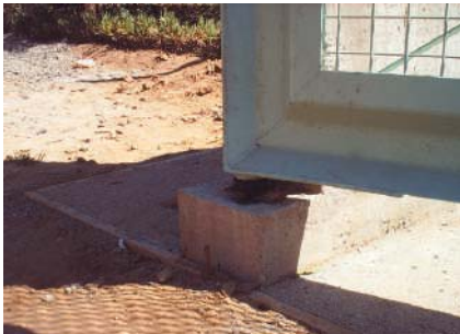
Gosnes de rotación. Fijación a solera del machón de hormigón.
