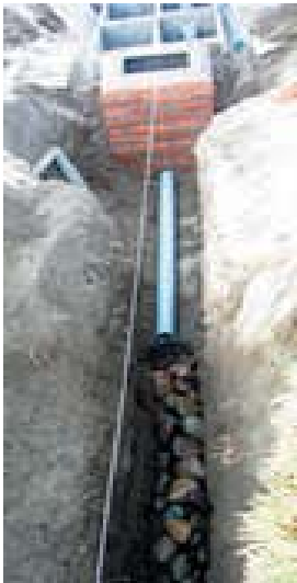
Tubo de salida de la cámara de inspección ,conexión con drenaje.
