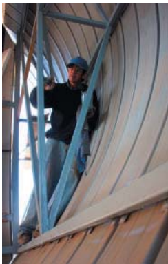
Pintado con anticorrosivo de la estructura de muros.
