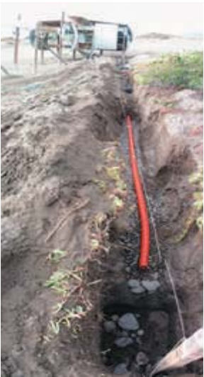
Colocación de huevillo en el fondo del dren y colocación del tubo especial para dren.
