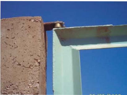
Gosne de rotación. Fijación al machón de hormigón.
