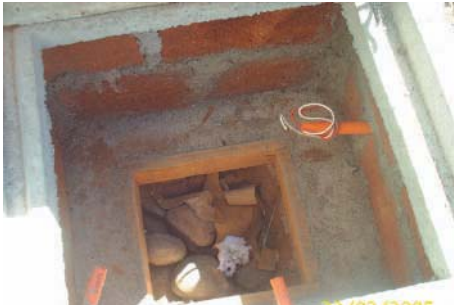
Cámara de inspección de red eléctrica.
