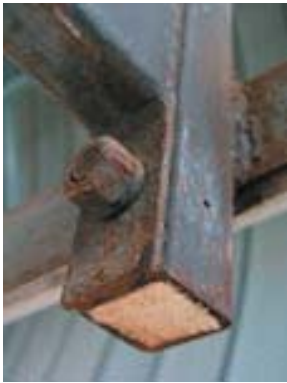
Tapas para prevenir la oxidación interna.
