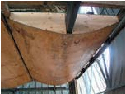
Tapa de terciado que cubre las vigas de fierro de los suelos colgantes.
