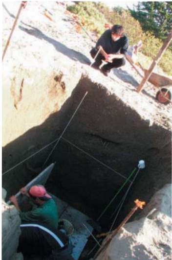
Trabajo en la construcción de cámara decantadora. Colocación de losetas prefabricadas de hormigón.
