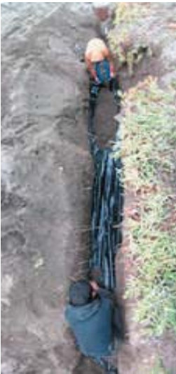
Cubrimiento con plástico del dren y posterior recubrimiento con arena de todo el drenaje.
