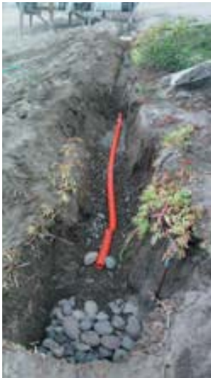
Construcción de pozo absorbente y colocación de bolones en el fondo de este.
