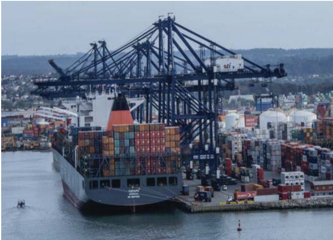
Figura 1-2 Grúa STS del tipo Panamax.
