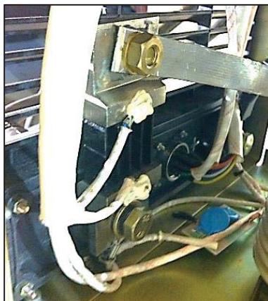
Fig. 11 Imagen del shunt en el interior de la máquina
