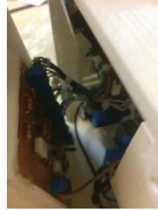
Figura A-33: Placa de control montada
