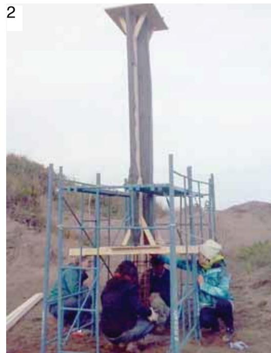
foto: amarre de la enfierradura de la columna con la de la fundación
