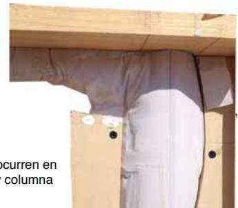
foto: detalle de las fallas que ocurren en el punto donde se unen viga y columna
