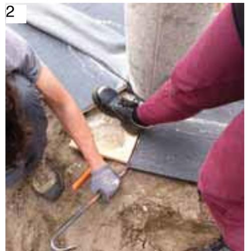
foto: el brocal se separa con la ayuda de herramientas (se hace una palanca).
