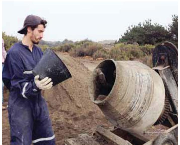
foto: preparación de la mezcla de hormigón.
