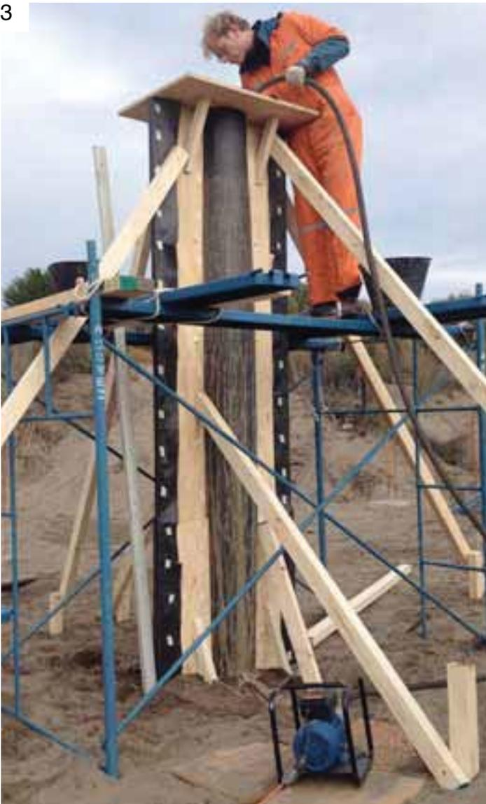
foto: vibrado de la mezcla al interior del moldaje
