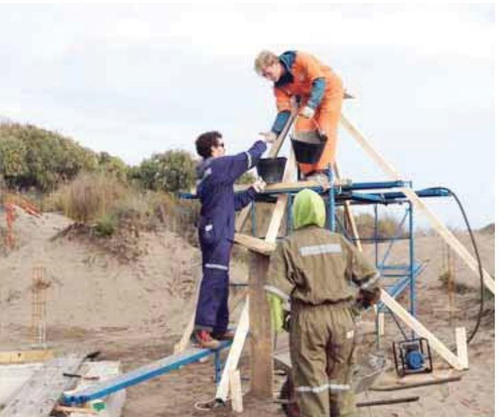
foto: proceso de llenado de un moldaje.
