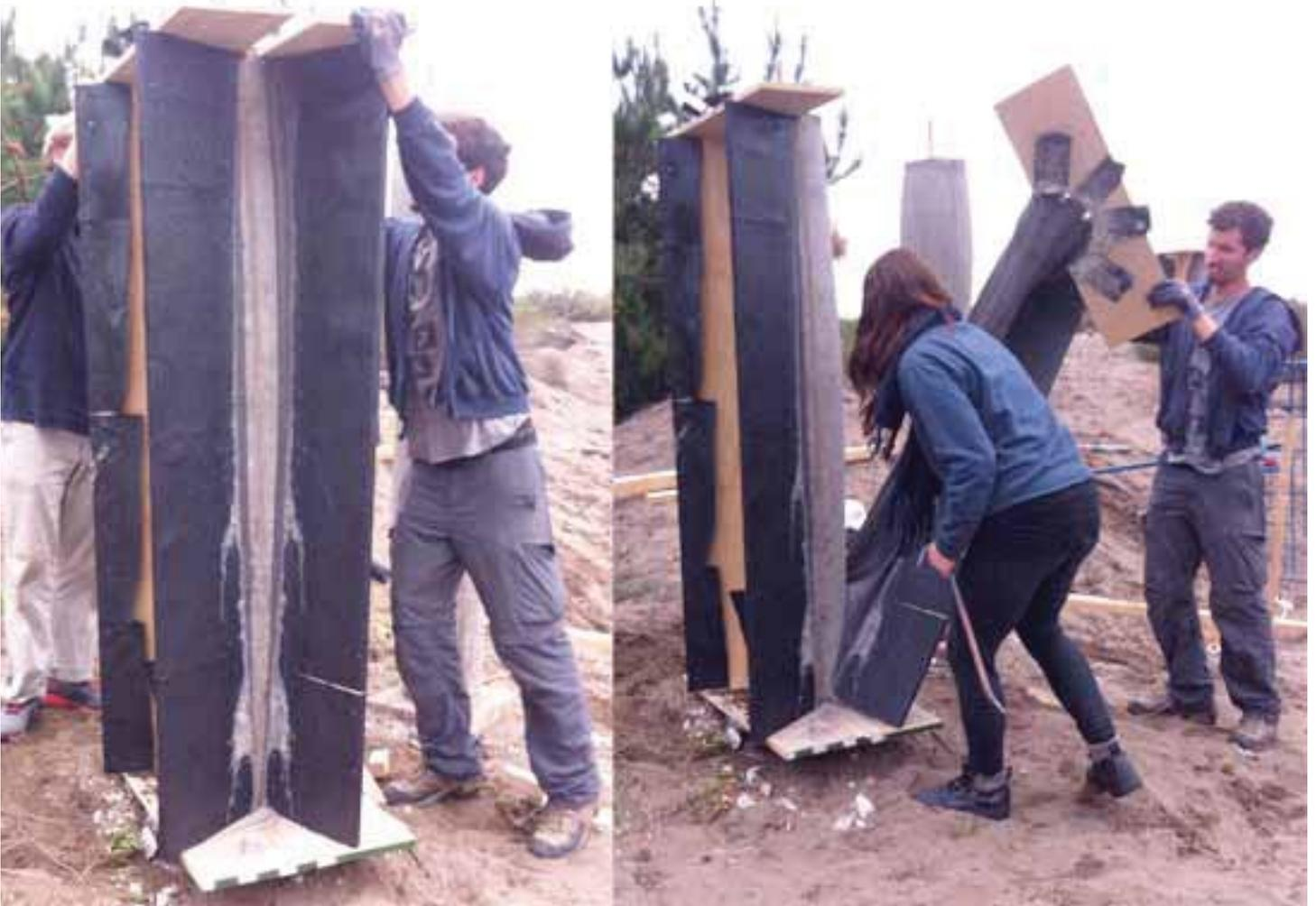
foto: momento en que se descubre la columna sacando todas las piezas que componen el moldaje.
