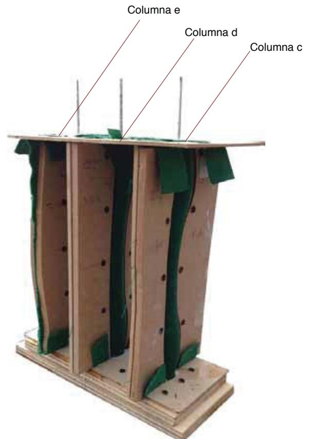
foto: estructura 3 moldajes simultáneos
