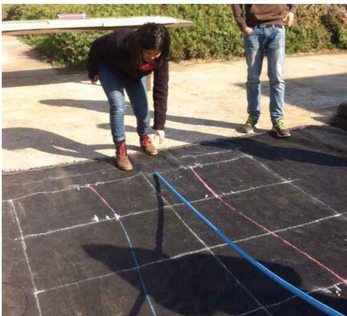
**2\_** Una vez que se marcan los puntos que crean la curva, se flexa el pvc sujetándolo en cada uno de los puntos, para luego dibujar la línea sobre la tela.
