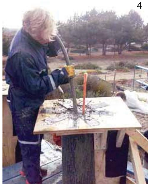
foto: vibrado de la mezcla
