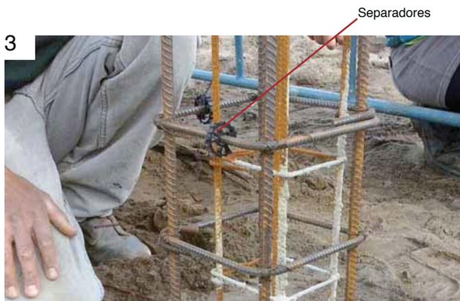
foto: instalación de separadores en la enfierradura
