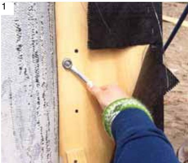
foto: primer paso para desmoldar: sacar pernos y tornillos.
