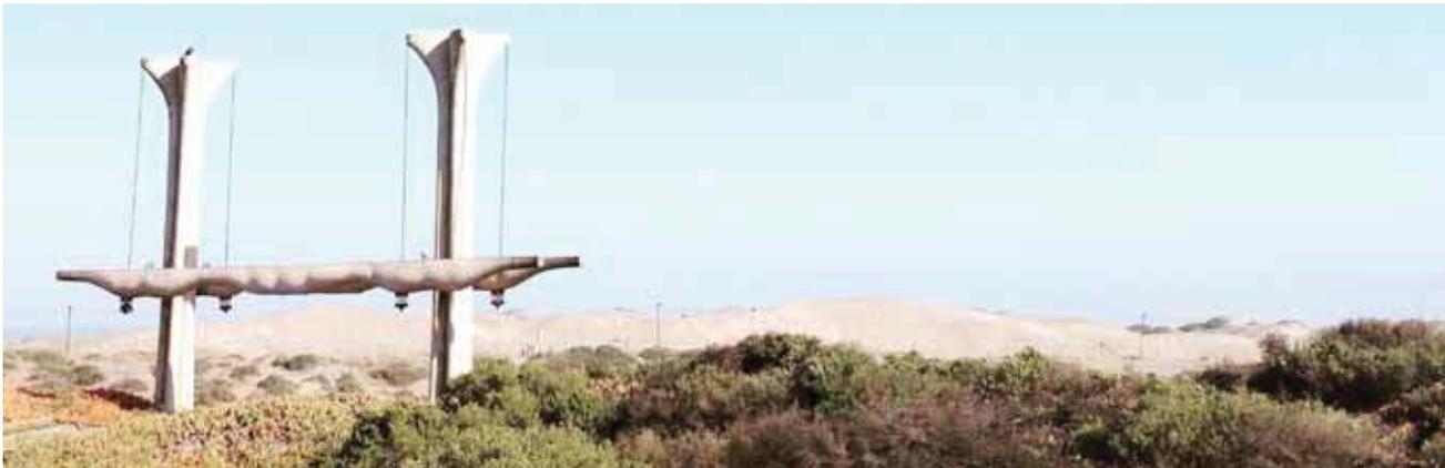
Pórtico construido con moldaje flexible.
