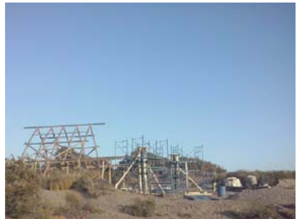
Panoráma general del lugar de la Obra, Pórtico de los Huéspedes.
