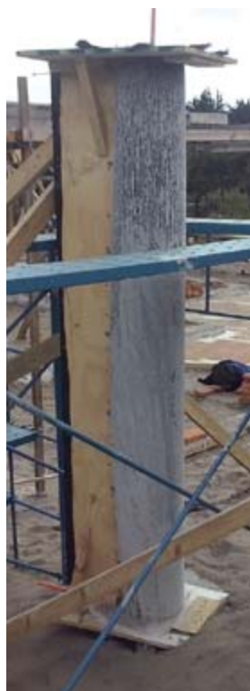
Moldaje Flexible Columna 02 A-14.
