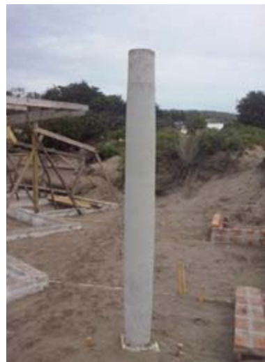
2) Columna de hormigón armado.
