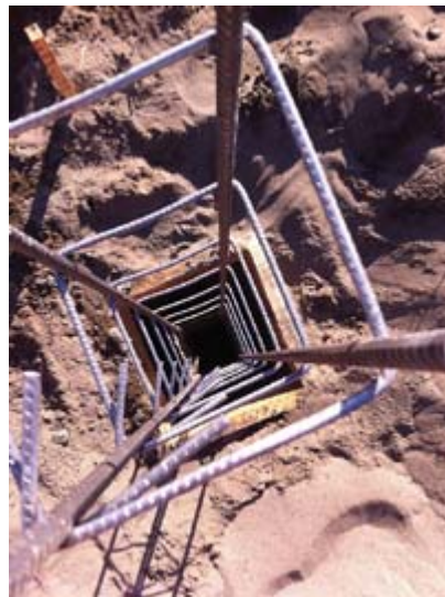
12) Pilar Acma en la excavación.
