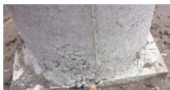
Marca de un gran nido en la zona inferior basal.
