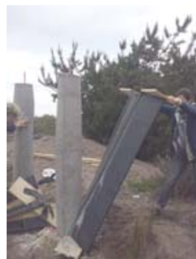
4) El moldaje flexible poseía 2 partes a partir del eje de las matrices, facilitando la faena de desmoldado, además de obtener las piezas intactas para volver a ocuparlas en otro moldaje.
