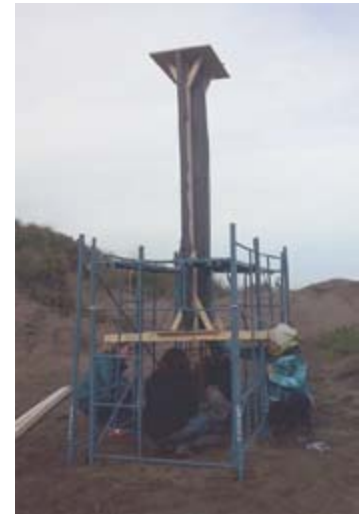
2) Los andamios sirven de apoyo para pasar listones que permitan el sustento del moldaje y así poder trabajar en el traslape de las enfierraduras.
