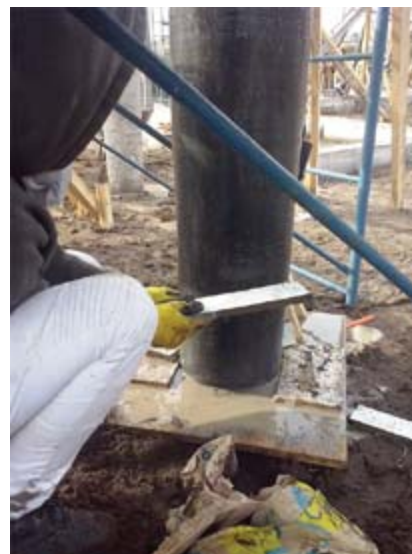
14) A medida que se va llenando, se debe ir corrigiendo y acomodando la mezcla desde el exterior -con las manos o con pequeños golpes-.
