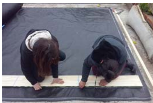
3.1) Tiras de madera utilizadas como regla por su lado recto.
