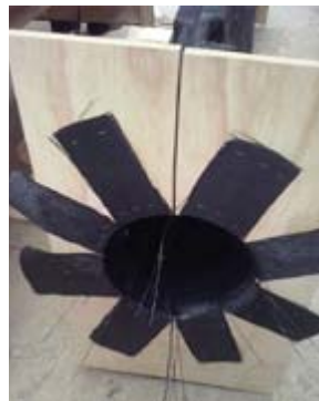
La zona de flequillos de la tela, se pasa por el orificio del brocal y se corchetea en él para tensar el geotextil.
