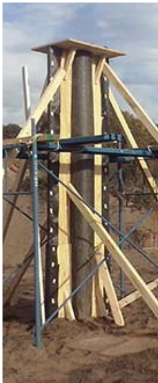
Moldaje Flexible Columna 07 C-4.
