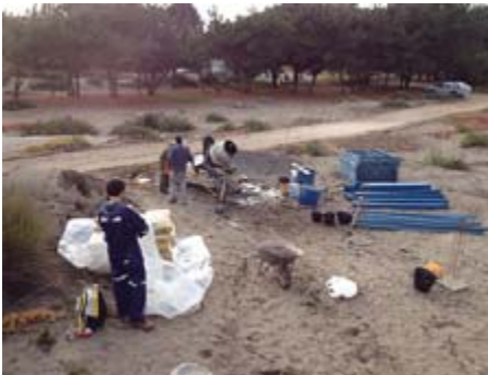
2) Área de mezclado de materiales para el hormigón. Ripio, Arena, Agua, Cemento, Betonera.
