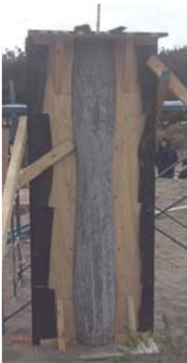
2) - 3) La columna tomó la forma cilíndrica y las curvas impuestas por el moldaje.
