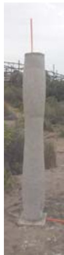
2) - 3) La columna tomó la forma cilíndrica y las curvas impuestas por el moldaje.
