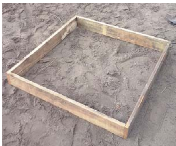
4) Encofrado de maderas de 1x5" de la Parrilla.
