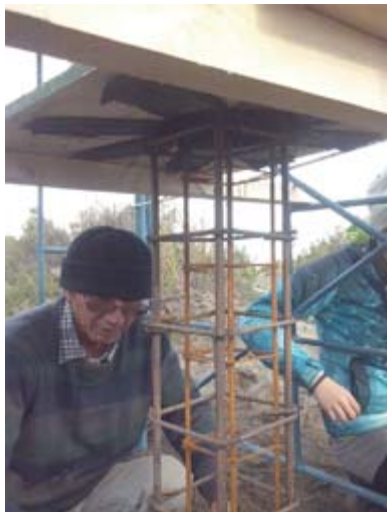
5) El moldaje se levanta y se apoya en listones que se colocan entre los andamios. Permite trabajar en el traslape de enfierraduras.
