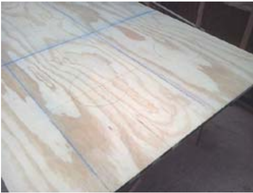
1) Dibujo lineal de brocales en la placa de madera terciado.
