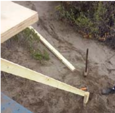
10) Luego traslapar enfierraduras, de pasar el conduit (tubo de pvc) por el interior de molde, y de centrar la estructura con respecto a la fundación, se procede a aplomar. Listones y estacas dejan la estructura aplomada.
