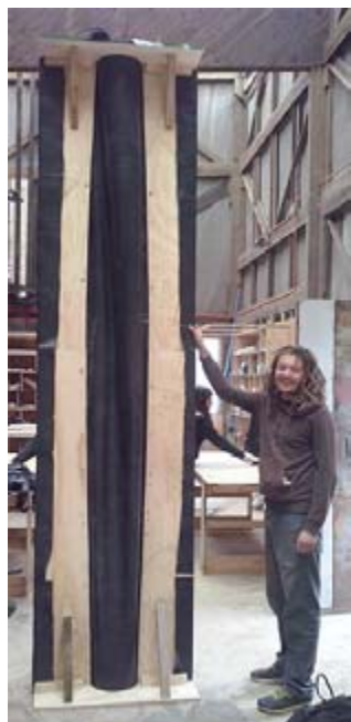
Moldaje Flexible Columna 07 C-11.
