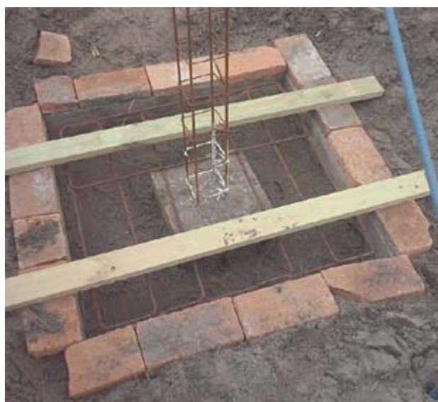
Enferradura dentro del encofrado -marco- de madera.
