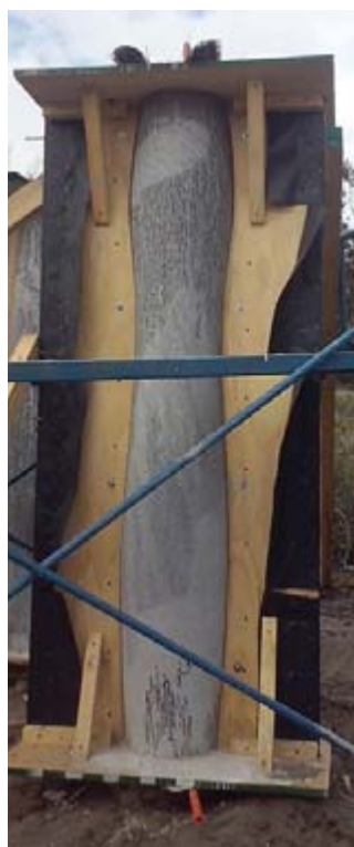
Moldaje Flexible Columna 08 C-16.
