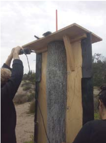
3) Sacar todos los tornillos y pernos de la estructura.
