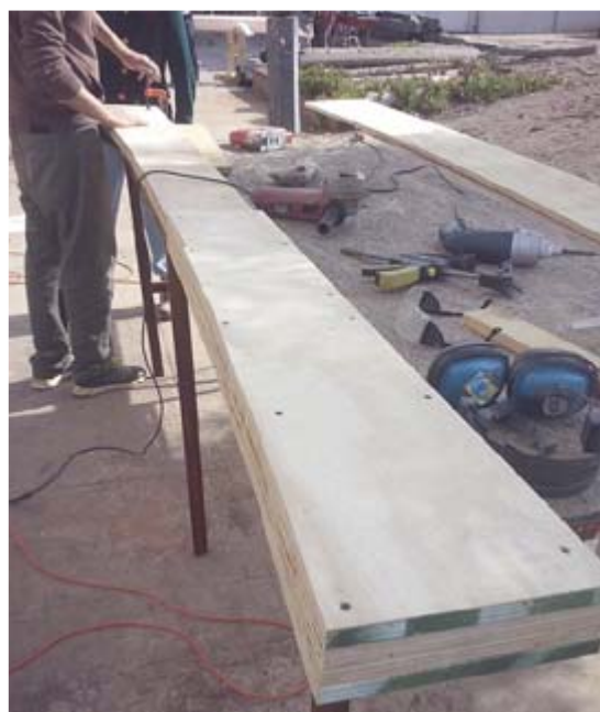
5) Si una matriz tiene 2 piezas en su altura, éstas se deben unir a través de una nueva pieza: el parche (tornillos).
