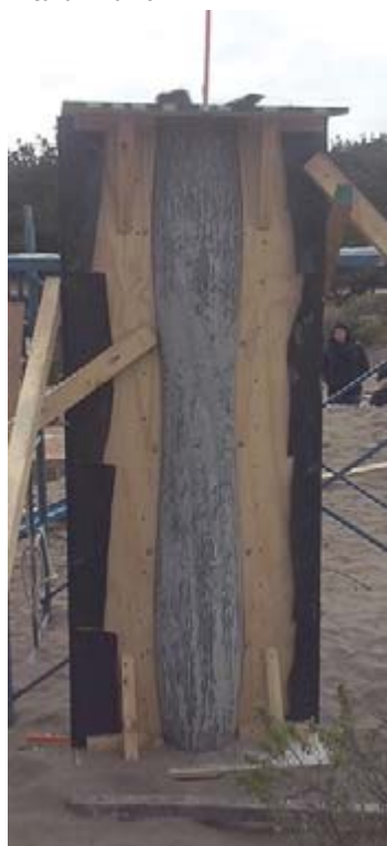
Moldaje Flexible Columna 08 C-13.
