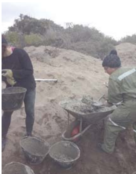
12) La carretilla se lleva al lugar del moldaje. Para el llenado se pasa la mezcla en baldes.
