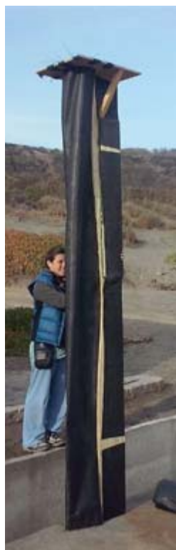
Moldaje Flexible Columna 01 A-7.
