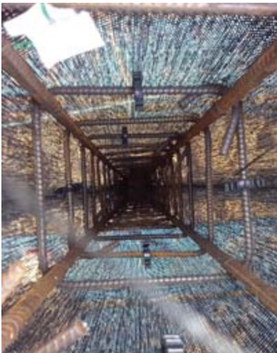
5) Enfierradura de la columna dentro de la tela. Ésta se ingresa una vez situado el moldaje en la enfierradura de la fundación.
