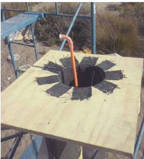
6) Conduit pasado por la parte superior. Permite tener electricidad si es necesario.
