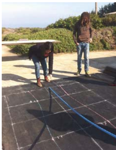
3.4) Dibujo de la línea curva utilizando un tubo de pvc -conduit-.
