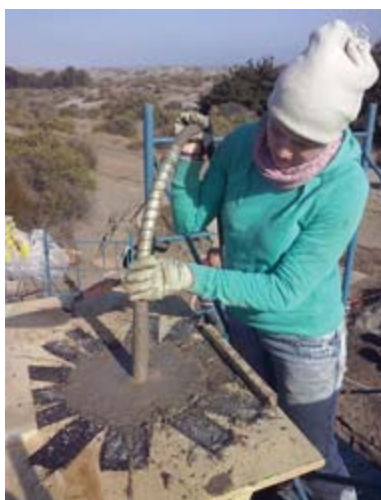
13) Una carretilla llena aproximadamente entre 50 a 60 cm de la altura de un moldaje. Cuando se traspasa la mezcla de una carretilla al interior, inmediatamente se utiliza el vibrador para expandir el hormigón homogéneamente.
