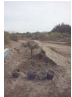
2.d) Arena. Siempre se dispone de la cantidad de baldes que necesita la mezcla (en este caso 4).
