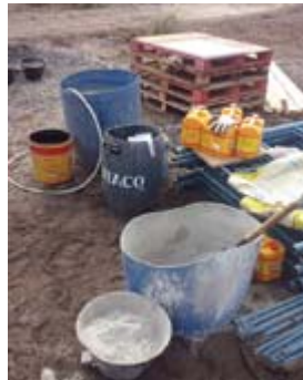
2.c) Recipientes, baldes y jarros para el agua y el cemento. Es imprescindible tener siempre el agua a disposición, la "sika" -acelerante de fraguado-, y el cemento.
