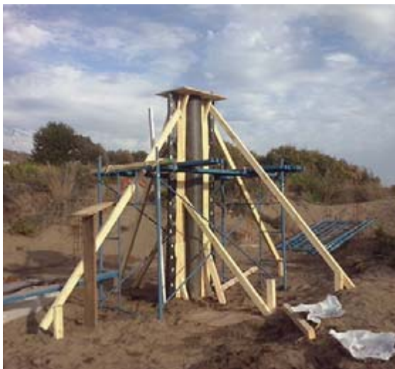
2) Estructura moldaje flexible, prototipo de columna.
