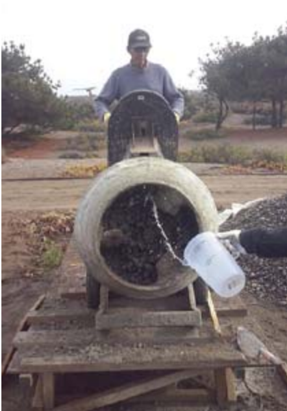
10) En la Betonera se realizó la mezcla de los materiales.
