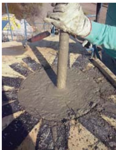
13) El vibrador permite que todo el aire dentro de la mezcla sea expulsado -burbujas-. Esto permite que no se produzcan "nidos". Proceso cada 1 carretilla y que dura 30" app.
