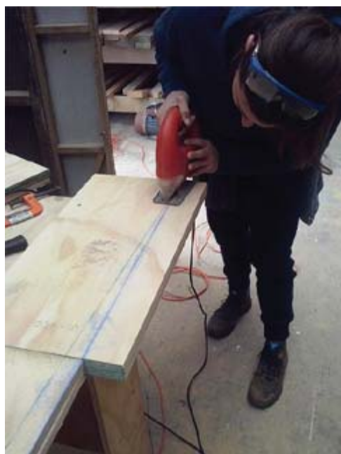
4) *En estas dos imagenes se puede apreciar que son dos piezas las que configuran la altura de la columna. Es con ellas dos juntas, que se dibuja la curva en un solo trazo. El corte de la matriz se realizó con caladora.
