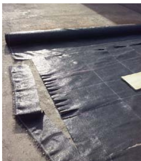
3.5) Corte de flequillos en la tela -ambos extremos-.
