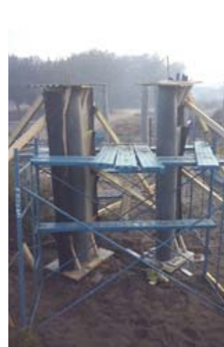
Moldajes Flexibles Llenos.
