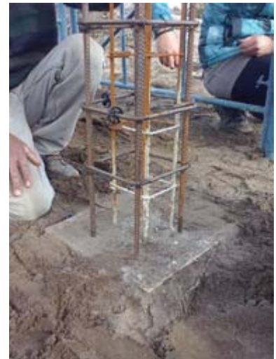
5) Traslape de enfierraduras.
