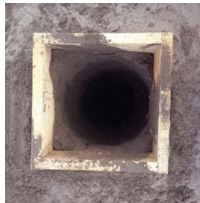
8) Resultado de la excavación con la Pala de Rotación.
