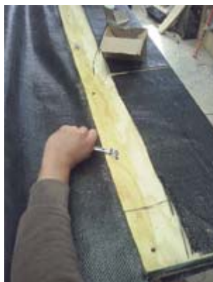
9) Los pernos se colocan desde 10-15 cm desde el borde, luego se separan entre sí cada 50 cm aproximadamente hasta llegar al otro borde.
