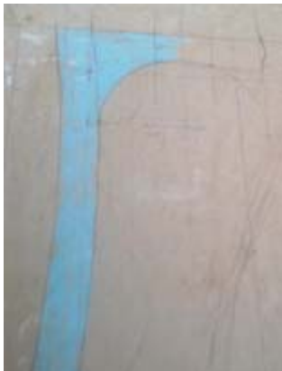
Imagen que muestra la línea continua entre columna y viga
