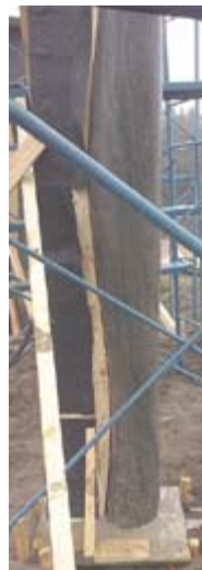
8) El geotextil (tela) permitió expulsar el exceso de agua del hormigón, dando una mejor dureza de la mezcla final.
