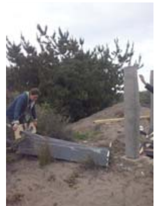
5) Se saca el conjunto de piezas y la columna queda a la vista.
