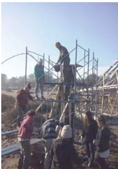
12) Cadena de traspaso de baldes con mezcla para llenar el moldaje.
