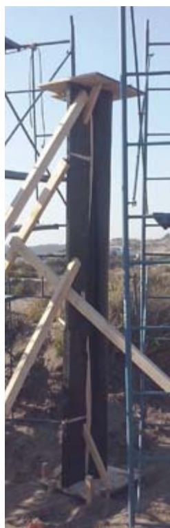
Moldaje Flexible Columna 01 A-9.
