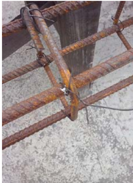
9) Unión con alambre negro de estribos y verticales.
