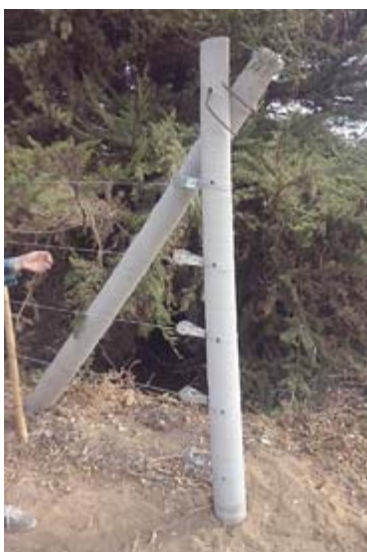
Foto Cerco acceso parte baja Ciudad Abierta hecha con Moldajes Flexibles
