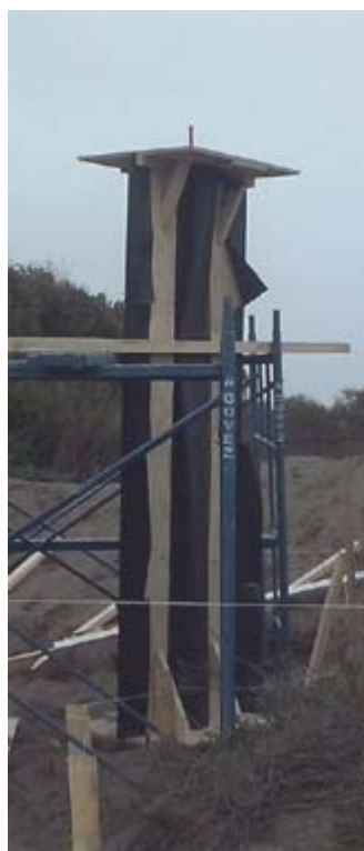
Moldaje Flexible Columna 03 B-2.
