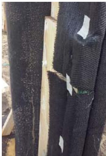
11) Los tornillos se tapan con cinta adhesiva para que no les caiga hormigón encima.
