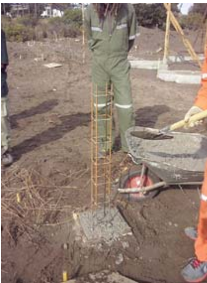
13) Llenado con pala de la fundación.
