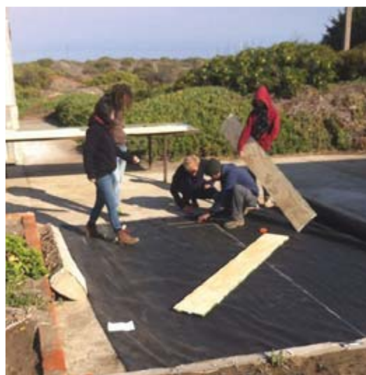
3) Dibujo en la tela de líneas guía para trazado de líneas curvas. Para trazar líneas tan extensas, se utilizaron tiras de madera terciado que poseían un lado recto (arista verde de la madera). De esta manera, con dos de estas tiras se pueden conseguir líneas perpendiculares.
