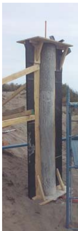
Moldaje Flexible Columna 04 B-17.
