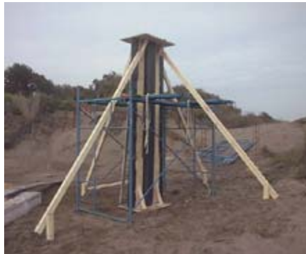
10.5) Estructura aplomada en los dos ejes.
