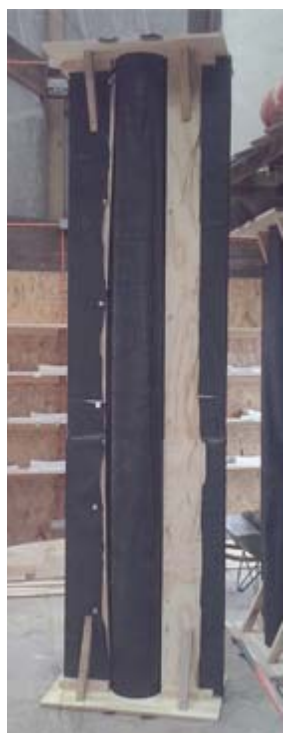
Moldaje Flexible Columna 03 B-10.
