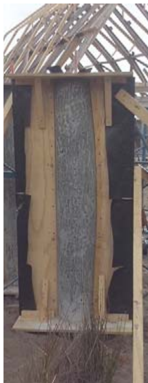
Moldaje Flexible Columna 03 B-15.
