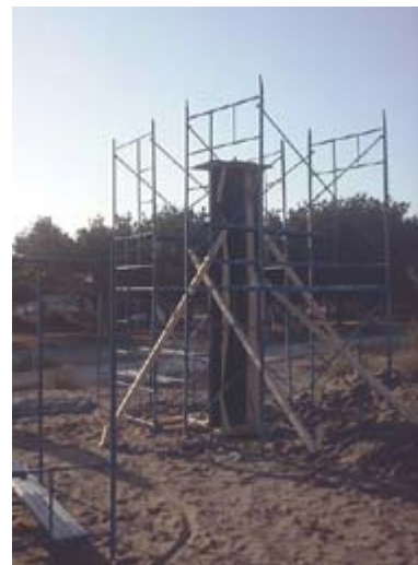
12) Andamios situados a los dos costados de la estructura.
