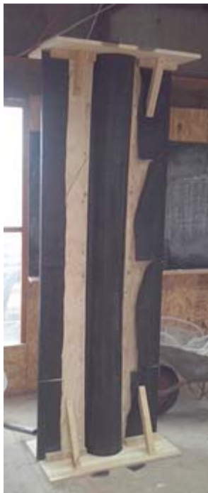
Moldaje Flexible Columna 03 B-15.
