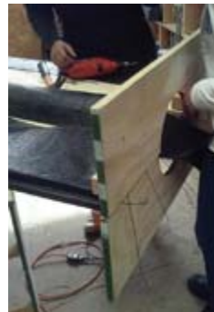
8) En el mismo procedimiento, se coloca la otra pieza del brocal.
