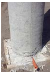
Nido en zona inferior de Columna
