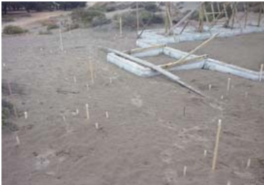
1) Trazado de estacas. Puntos de cada columna- fundación. Cada estaca de columna tenía 4 pequeñas estacas que la rodeaban. Formaban una cruz con una lienza sobre ellas, obteniendo el punto exacto del centro donde se hizo la excavación.
