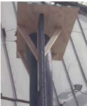
Diagonales de soporte de la estructura.
