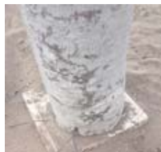
Marcas de arrugas en zona inferior basal.
