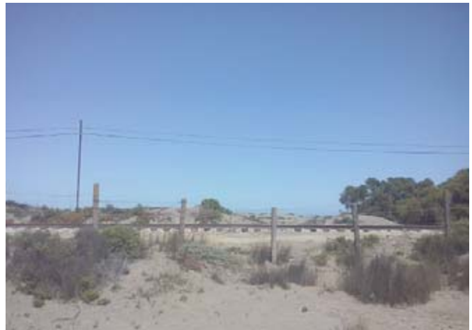
Foto Lugar de la Obra - Cerco Límite Predial
