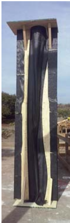
Moldaje Flexible Columna 05 B-8.
