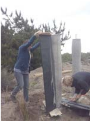
5) a estructura rígida está pensada en su armado para poder desarmarla en dos partes fácilmente. Esto quiere decir que los brocales se componen de 2 piezas y éstas se separan en el mismo eje que el de las matrices.
