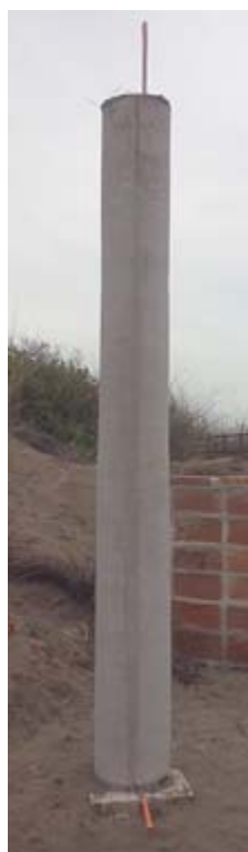
Moldaje Flexible Columna 04 B-1.
