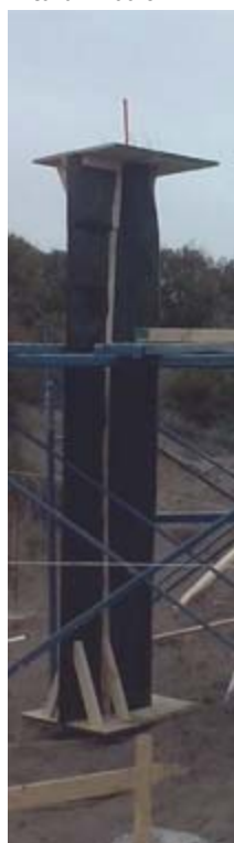
Moldaje Flexible Columna 02 A-3.
