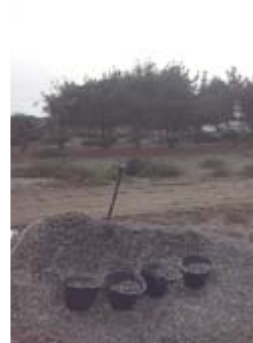
2.d) Ripio. Siempre se dispone de la cantidad de baldes que necesita la mezcla (en este caso 4).
