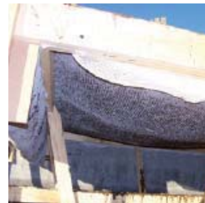
Construcción a media escala, de una sección de losa, con configuración de subdivisión ortogonal. (Loseta de gran tamaño, en conjunto con una viga y dos viguetas, con nudos ortogonales).
