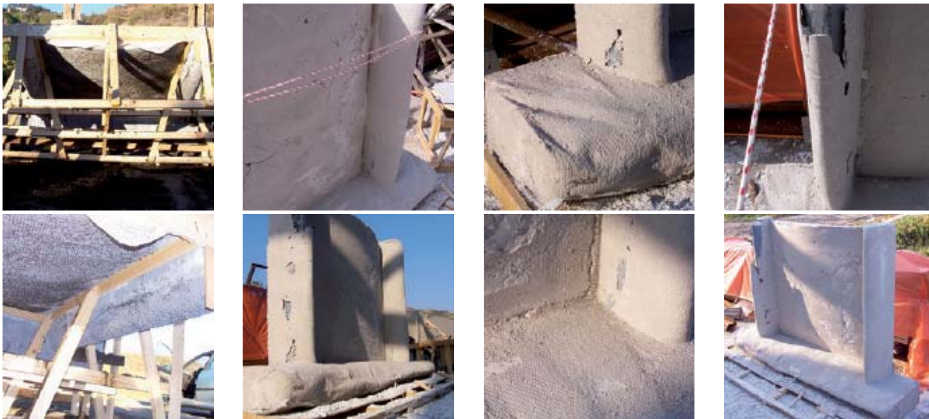
Construcción a media escala, de una sección de losa, con configuración de subdivisión ortogonal. (Loseta de gran tamaño, en conjunto con una viga y dos viguetas, con nudos ortogonales).
