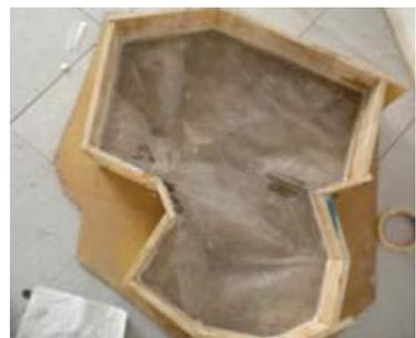
Encofrado listo para vaciarle el hormigón.
