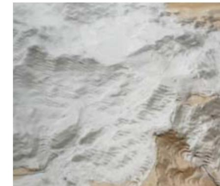
La huella de la fresa se borra con la pasta de muro.
