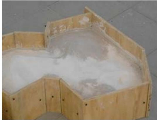
Construcción de encofrados para cada pieza.
