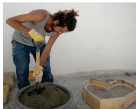
Mezcla de un balde de arena por uno de cemento.
