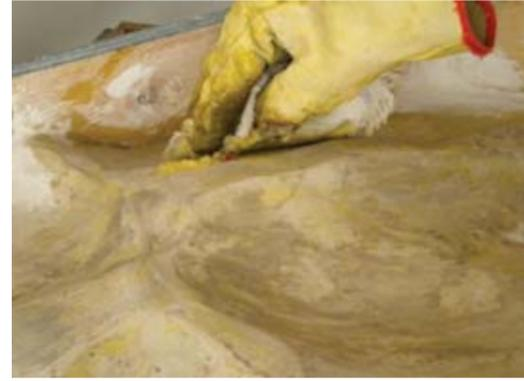
Se aplica una capa de cera desmoldante sobre cada encofrado cuidadosamente para las pruebas de moldaje siguientes.
