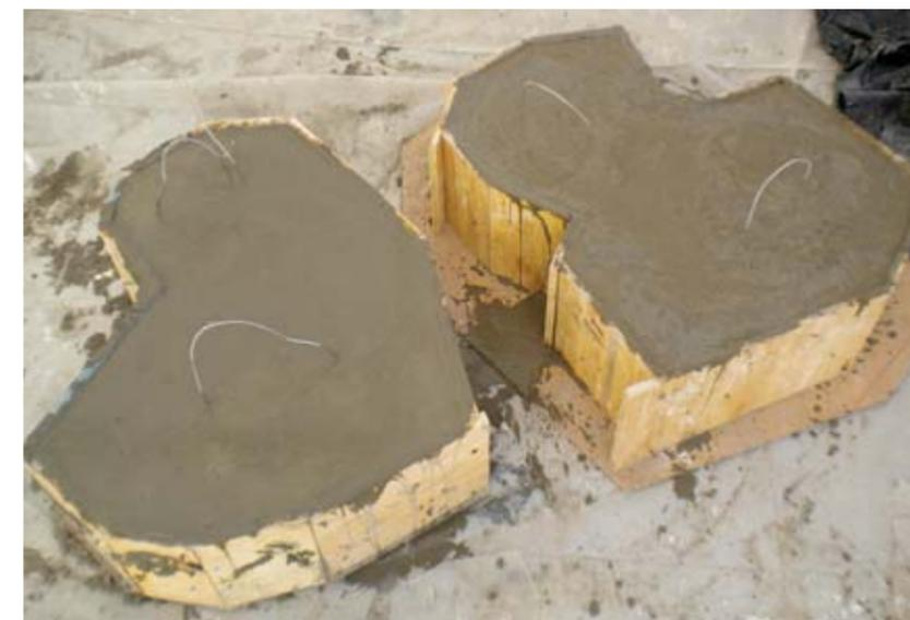
Encofrados llenos de hormigón, 4 días de secado
