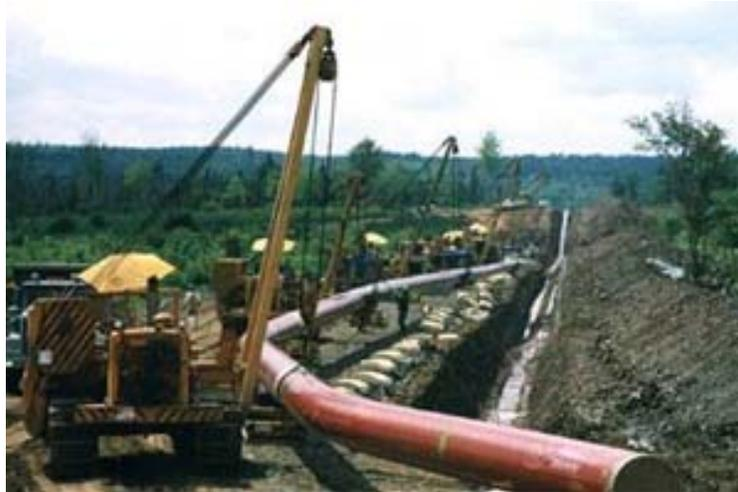
**Figura 2.43:** Maniobras de instalación de gasoducto en la fosa.
