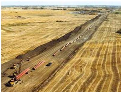
**Figura 2.42:** Presentación de las tuberías al lugar de instalación
