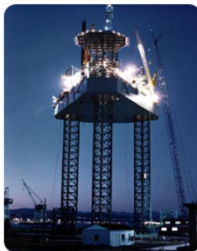
**Figura 2.24:** Equipo Jack-Up en construcción [42]
