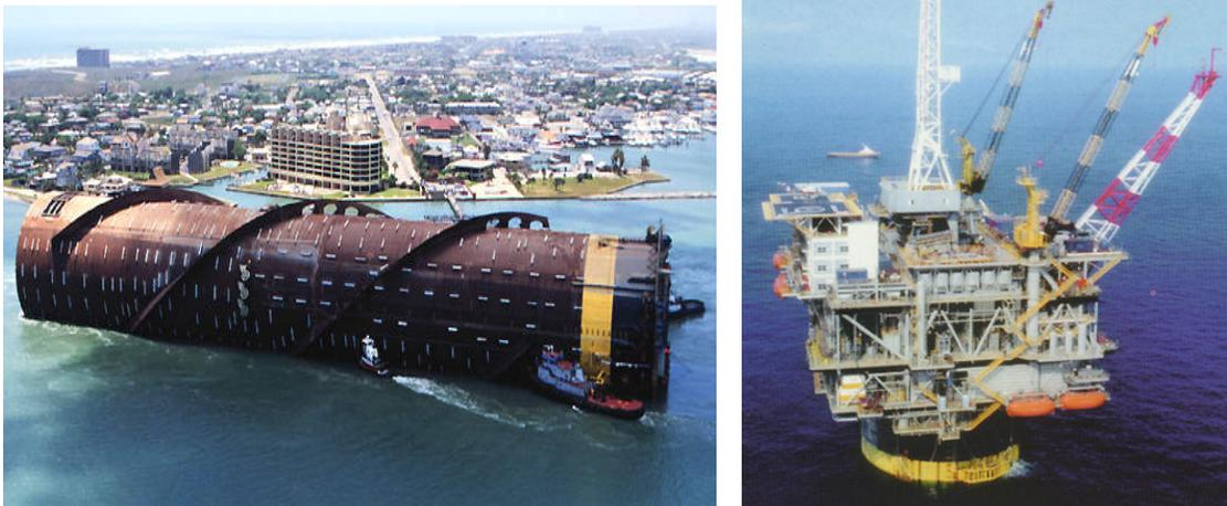
**Figura 2.30:** Plataformas de mástil (Spar Platforms) [45].
