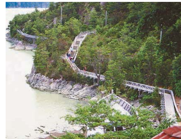
Sistema de pasarelas en Caleta Tortel
