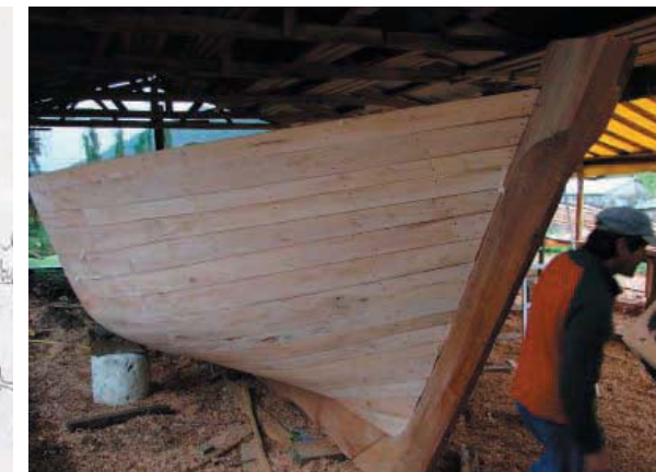
Casco Chilote en construcción
