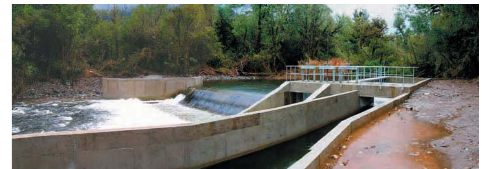
Mini central eléctrica de Hornopirén
