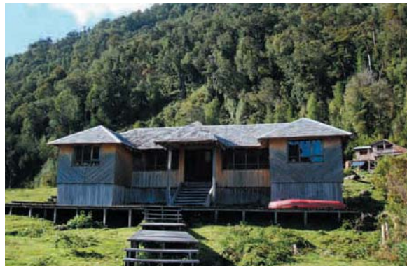
Hospedería en Vodudahue
