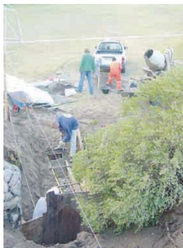
018 moldaje cimientos para muro de contención acceso .
