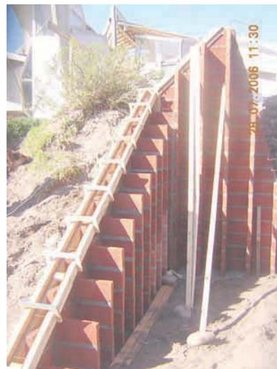
060 cinta que se vincula a los cimientos constituyendo un muro de albañilería reforzada.
