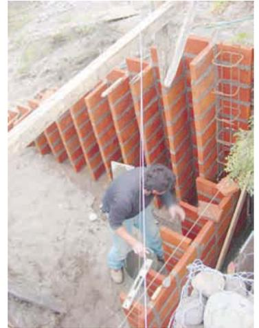
039 la unión de los muros es por medio de un vértice pilarizado de hormigón armado.
