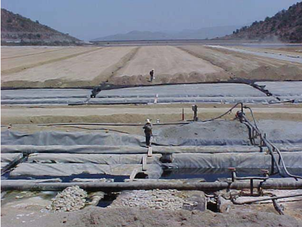
Figura 8. Construcción de Cancha de Lixiviación. División El Soldado
