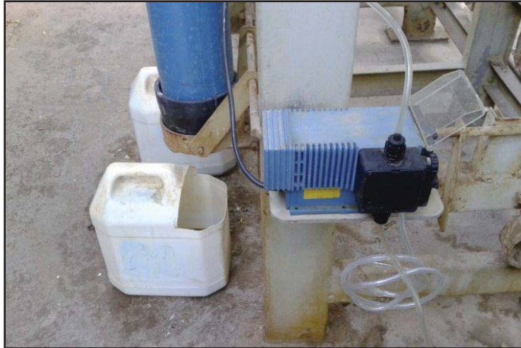
Figura 14. Bomba de membrana, alimentación principal a columnas.
