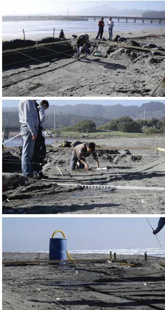
Fig. 104. Construcción del Modelo a través de Cerco de Niveletas y posterior modelación con arena. Luego, se agrega la infraestructura hidráulica, las dimensiones del modelo eran de 15 mt por 5 mt.
