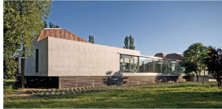
Fig. 47. Fotografía del centro de interpretación de los ríos. Fuente: plataformaarquitectura.cl
