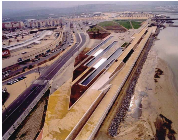
Fig. 38. Panorámica que muestra las vistas del proyecto.
