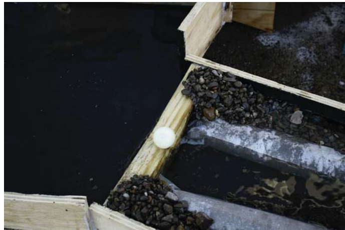
Fig. 92. Serie de fotografías al momento de la modelación. Se utilizan mangas de plástico de e=0.2mm de 10 cm de ancho rellenas de arena obtenida en el lugar para este propósito, y se complementan con piedrecillas. Se observa la trayectoria de una pelota de ping pong. Aumenta su velocidad en tanto la sección se hace menor. Al construir los bordes de elementos móviles se puede mover para obtener una velocidad requerida.
