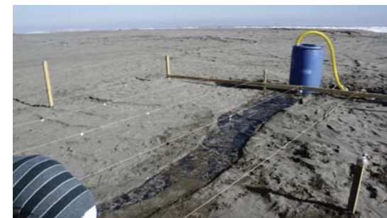
Fig. 105. Faenas de pruebas, a través de una bomba, se extrae agua del estero para proveer un flujo continuo a través del modelo, se prueba distintos caudales.
