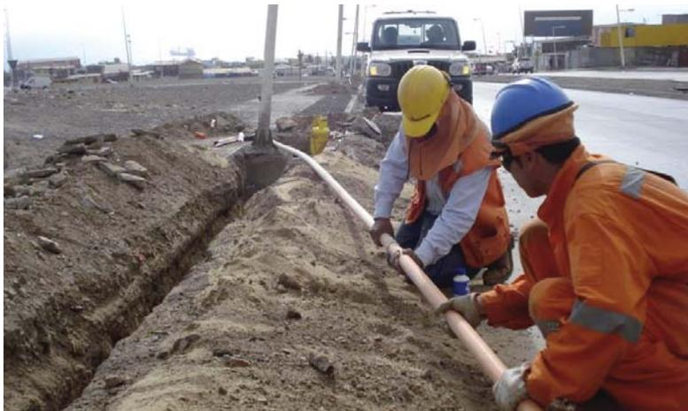
*Figura 29. Ejemplo de tendido subterráneo.*
