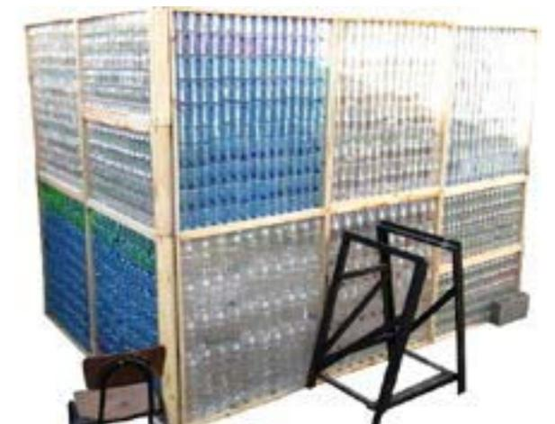
El levantamiento de muros se hace una vez que han sido vinculados los paneles. El muro de 3 x 2,20 mts se completa con 5 paneles de 1 x 1,10 mts y 2 paneles de 100 x 55 cms. La medida de este panel más pequeño se determina por el uso que se le quiere dar, un horizonte luminoso. Se divide por la mitad el panel más grande y se mantiene el ancho de 1 mt para vincular de esta forma paneles grandes y pequeño. Se proyecta la apertura de una ventana.
