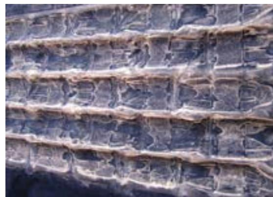
Momento en el que se aplica el cemento sobre la tela y su posterior resultado, dejando una tela rígida con la forma redondeada de las columnas al secarse el cemento.
