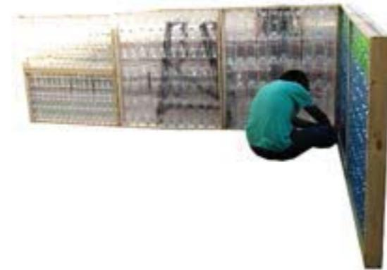
Unión de paneles en sentido vertical y horizontal, enterando en la vertical 2,20 mts y en la horizontal una medida que puede variar según la cantidad de paneles que se quiera utilizar. Anterior a esto, se construye un cubo con paneles para hacer pruebas de vinculación y resistencia.
