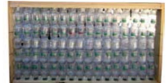
Panel luminoso y transparente pensado como una ventana por la cual ingresa luz al interior. La medida de un posible horizonte de luz continuo hace modificar la altura de los paneles ya nombrados, quedando de 55 cms de alto x 100 cms de ancho. Esta altura se ajusta a la mitad del panel - muro (110 x 100 cms) dejando la posibilidad de unir otro panel de esta misma medida, y enterando así 100 cms de alto que se pueden juntar con cualquier panel - muro.
