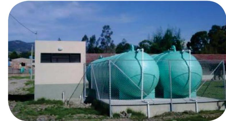
TANQUES PARA ALMACENAMIENTO DE AGUA Y OTROS LIQUIDOS EN FIBRA DE VIDRIO
