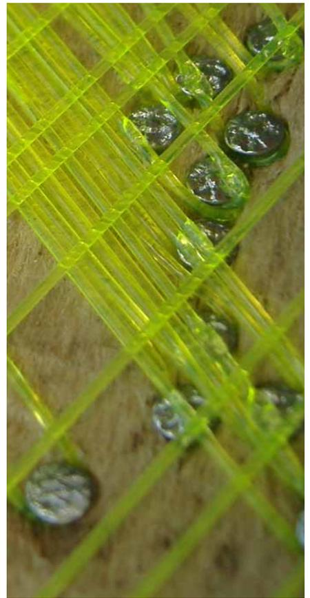
detalle de fijación de los hilos a la madera
